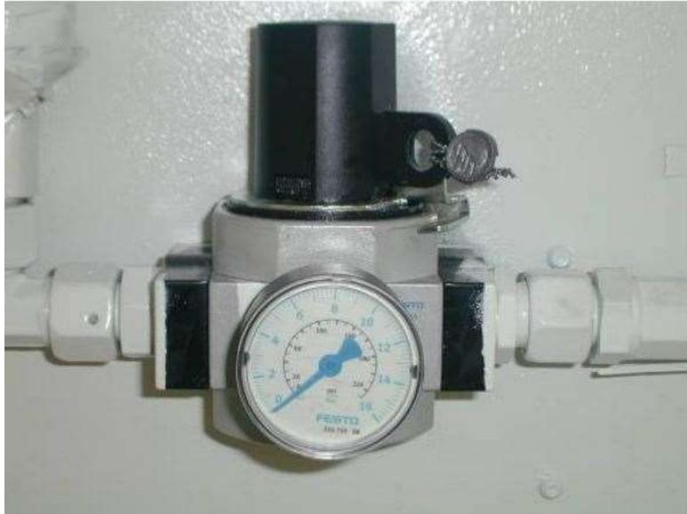
*Figura3.7: Manómetro del sistema anti sobrecargas*
