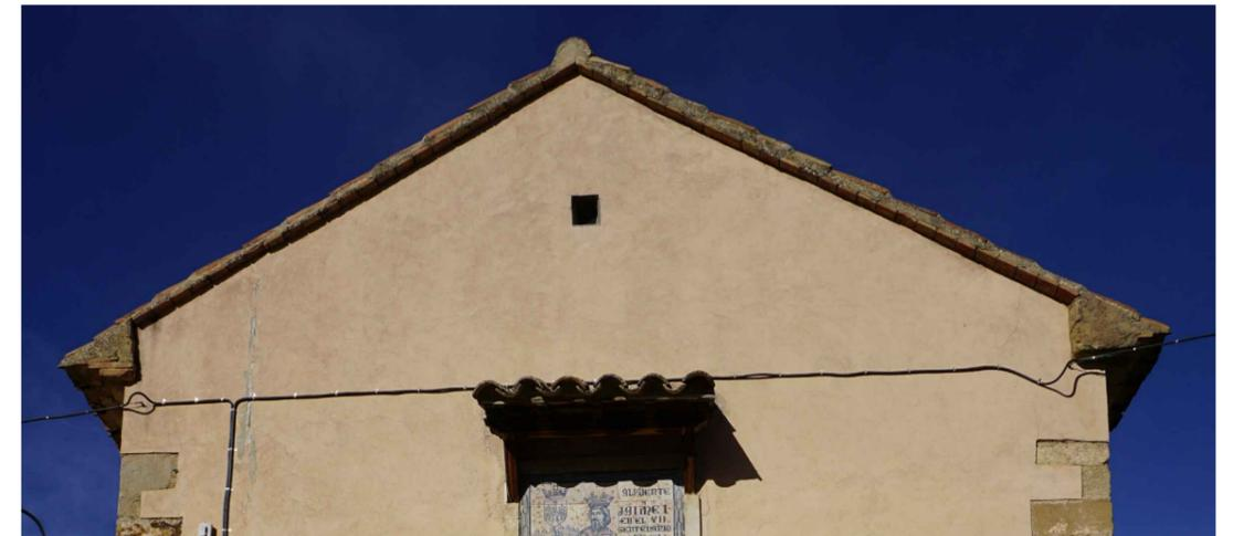
Fig. 61 Imagen Cubierta inclinada con entabicado de rasilla, Salón Consistorial Torre de la Aljama en Alpuente Valencia (fuente propia)
