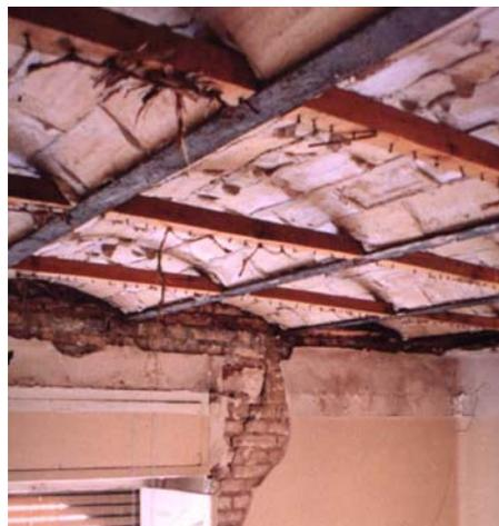
Figura 2. Viguetas oxidadas en forjado cubierta por filtraciones, Valencia
