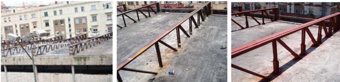
Figura 1. Cerchas metálicas, antes y después de la reparación, Valencia
