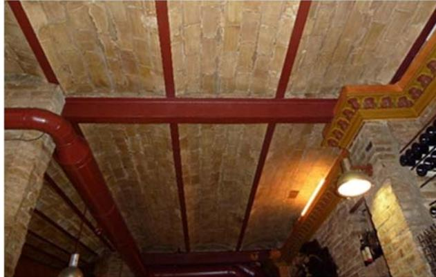
Figura 3. Forjado de viguetas metálicas, Valencia
