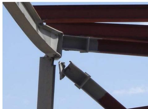
Figura 4. Fallo de la unión entre elementos metálicos. Valencia
