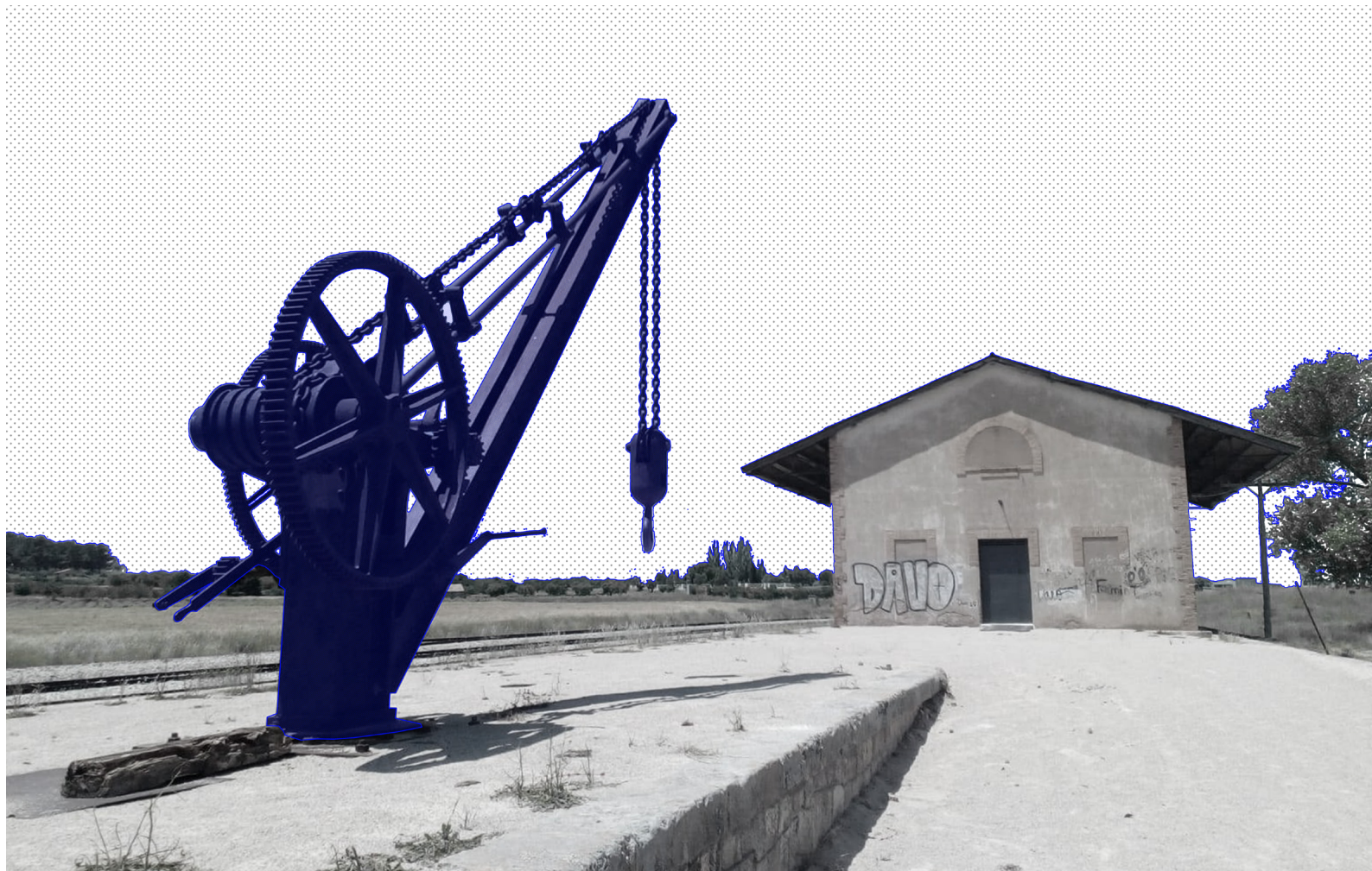
Figura 27 | La emblemática grúa de la estación de Camporrobles permanece impassible ante el paso del tiempo. Fuente: Elaboración propia
