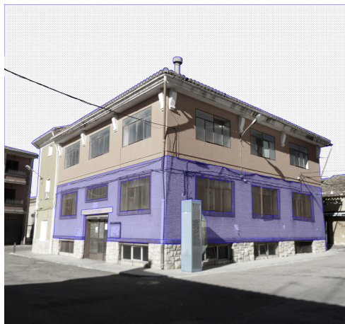
Figura 42 | Estado actual de la antigua panificadora. Fuente: Elaboración propia
