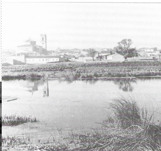
Figura 10 | Vista de la Balsa. Fuente: Imágenes para el recuerdo. R. Gómez
