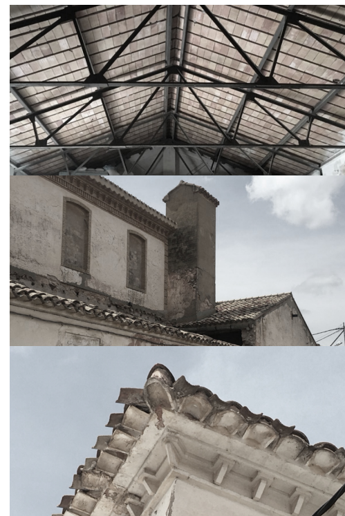
Figura 51 | Detalle cerchas metálicas. Fuente: Elena Bosque. Arquitecta Municipal 2000-2009
