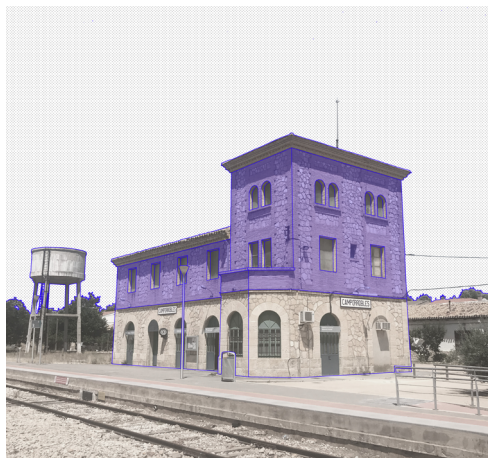
Figura 41 | Estado actual de la estación de Camporrobles. Fuente: Elaboración propia
