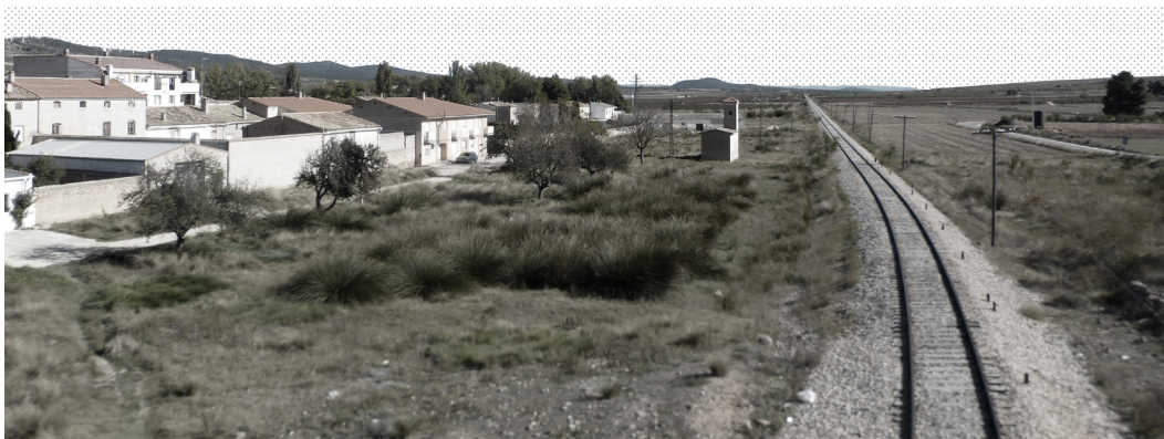
Figura 17 | Vista al este desde el puente de Fuenterrobles a la entrada a Camporrobles. Fuente: Elaboración propia
