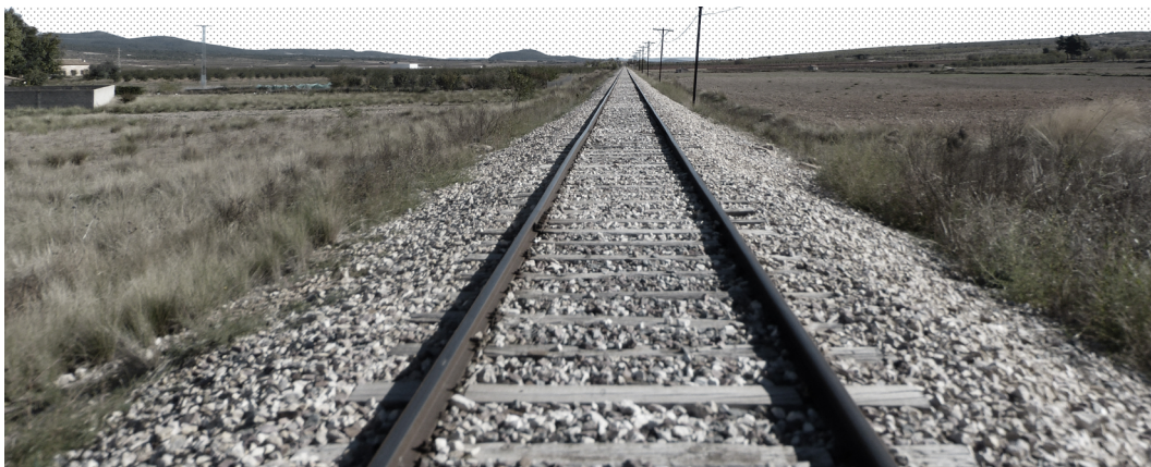
Figura 25 | Vías del trazado del eje del ferrocarril. Fuente: Elaboración propia
