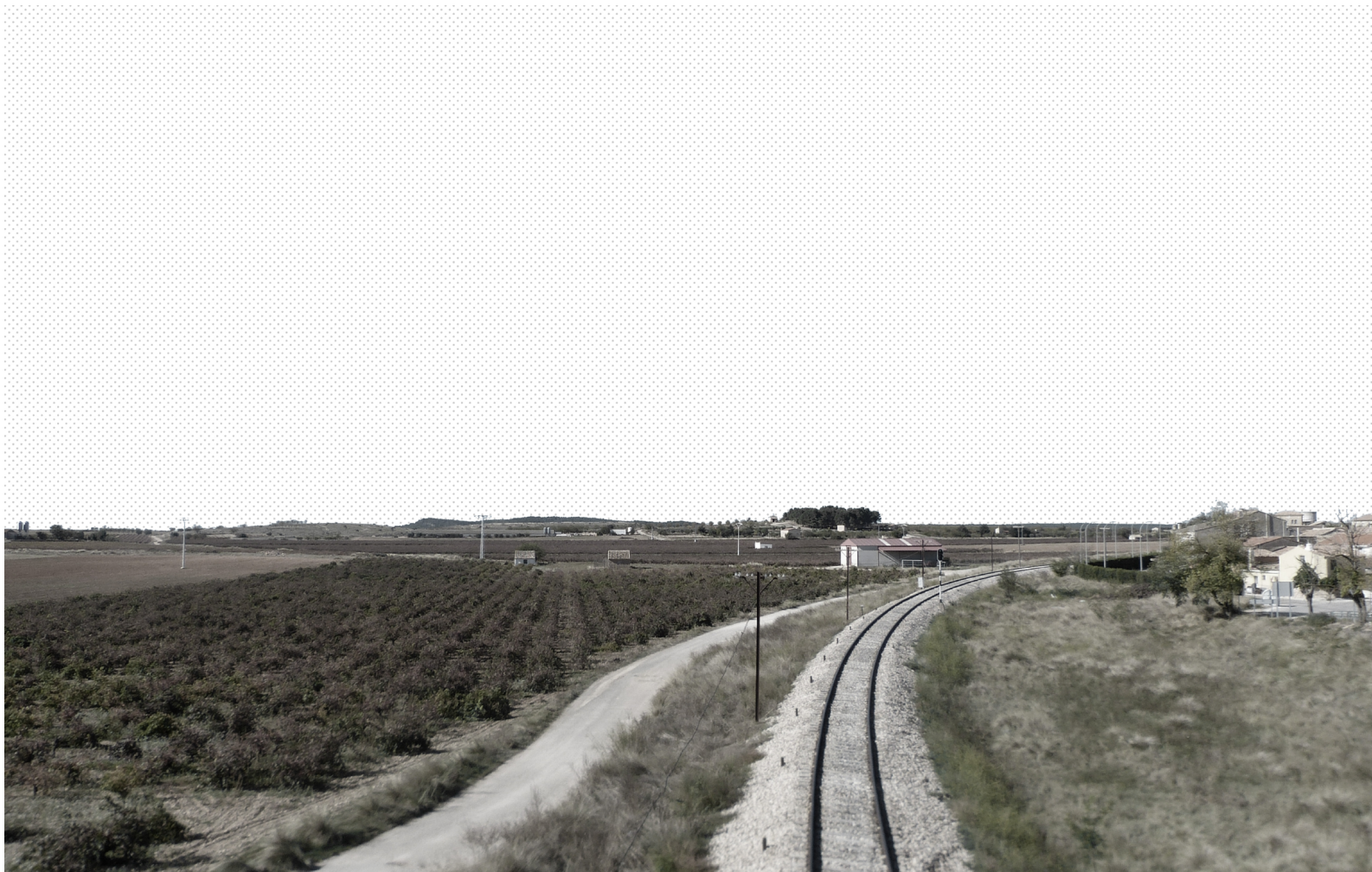
Figura 7 | Vista desde el puente de la CV-475 de acceso a Camporrobles desde Fuenterrobes. Elaboración propia
