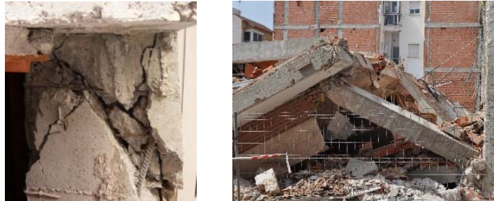
Figura 6. Daños causados por el sismo de Lorca (mayo 2011)
