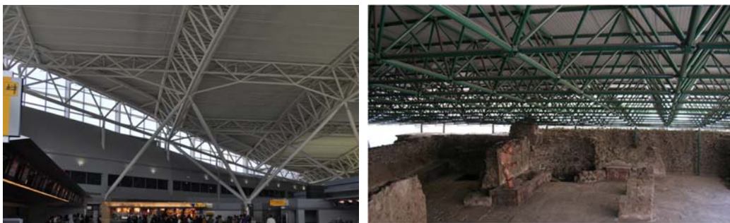
Figura 5. a) cubierta aeropuerto JFK, NY, b) cubierta plaza Zócalo, Méjico DF.
