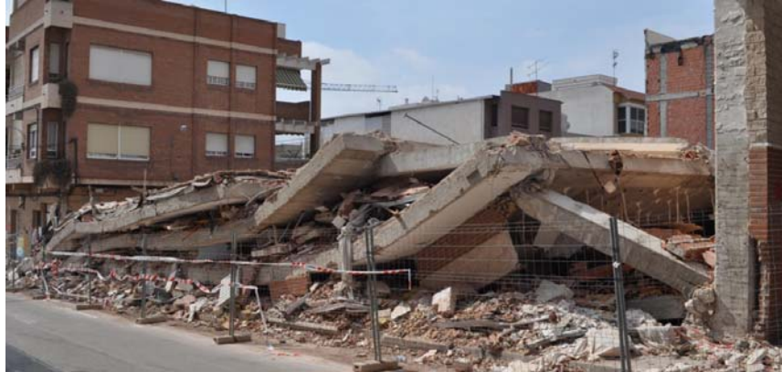
Figura 3. Edificio colapsado en Lorca, por el terremoto de mayo de 2011
