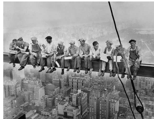
21_Obreros durante la construcción
