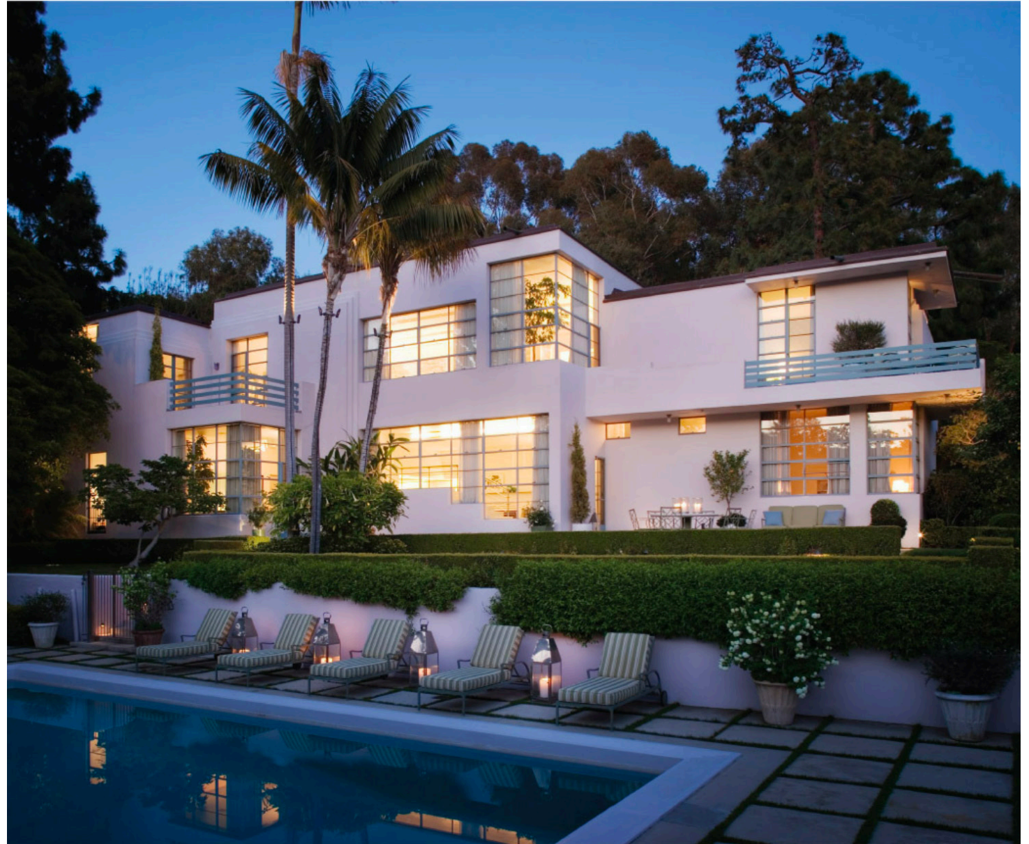
53_Casa de Cedric Gibbons y Dolores del Río. Parte trasera de la casa con la piscina hoy en día
