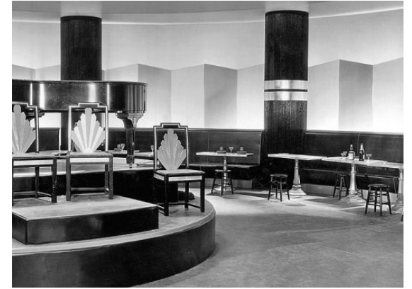
87_Salón Amarillo del Gran Hotel. Detalle de los respaldos de las sillas
