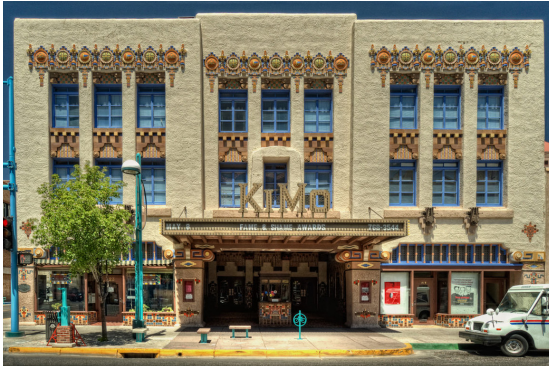
11_Fachada del Teatro KiMo (1927) en Albuquerque
