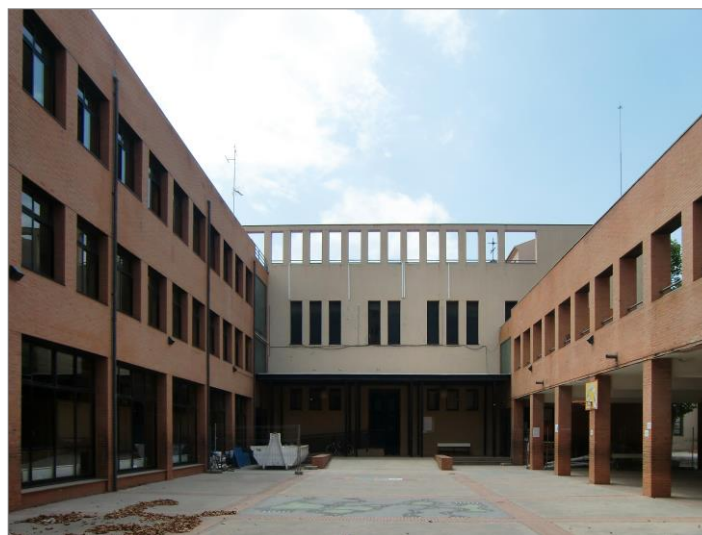
Fig. 61. Patio de recepción, formando un claustro descubierto. Bajo el brazo derecho se encuentra el espacio cubierto del patio, sobre el cuál debía construirse un gimnasio. Fuente: Elaboración propia.
