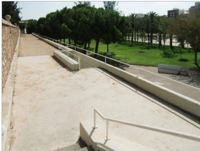
Fig. 37. Acceso junto a la Casa del Agua. Fuente: Elaboración propia.
