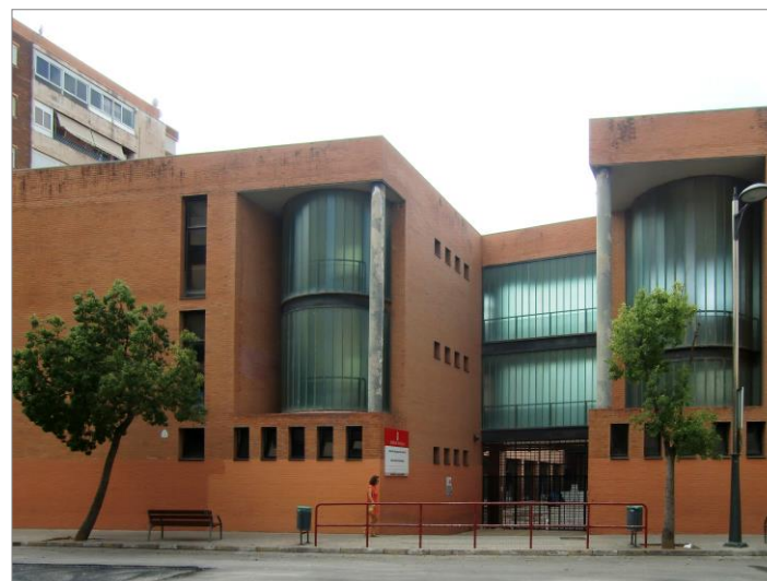
Fig. 60. Pabellón de acceso, recayente a la avenida principal. Destacan las formas cilíndricas realizadas con vidrio y el acceso retranqueado. Fuente: Elaboración propia.
