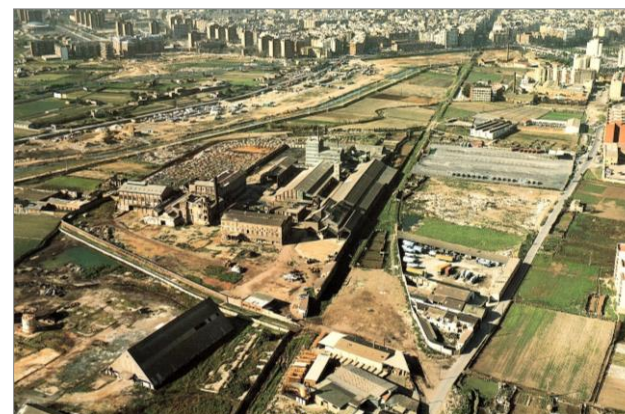
Fig. 70. Fotografía aérea del sector previa a la realización del PAU. Fuente: PAU Avenida de Francia.
