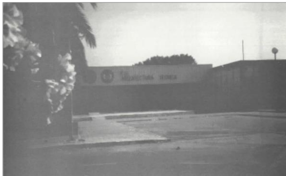
Fig. 6. Instituto Politécnico Superior. Fuente: Libro Historia de la Escuela Técnica Superior de Arquitectura de Valencia 1965-90.
