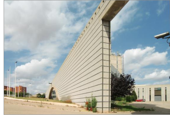
Fig. 49. Fachada de acceso. Fuente: Elaboración propia.
