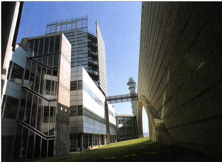
Fig. 48. Vista interior del conjunto. Fuente: Revista On.
