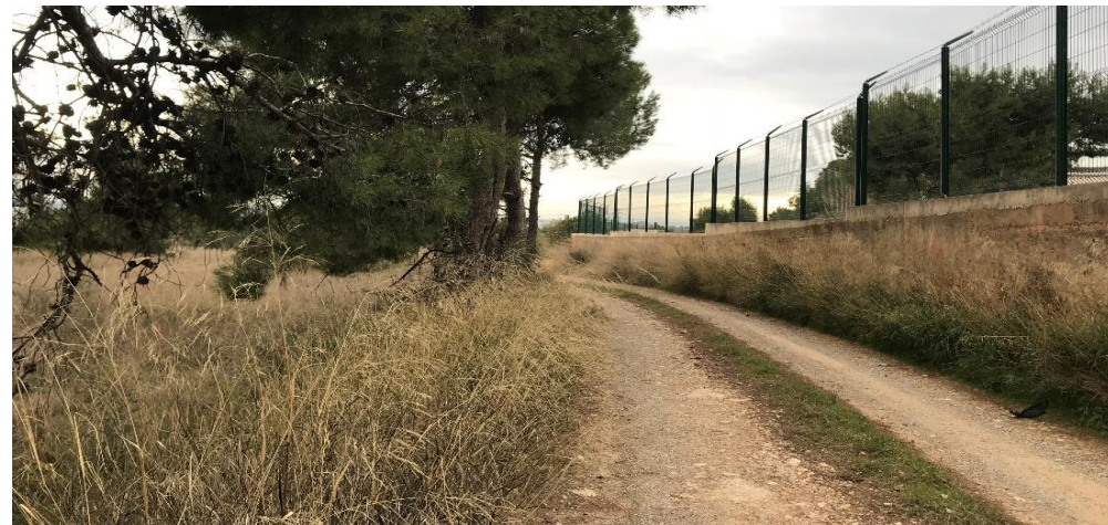
Figura 9. Estado de la carretera calle Polígono 13, cuenca N2
