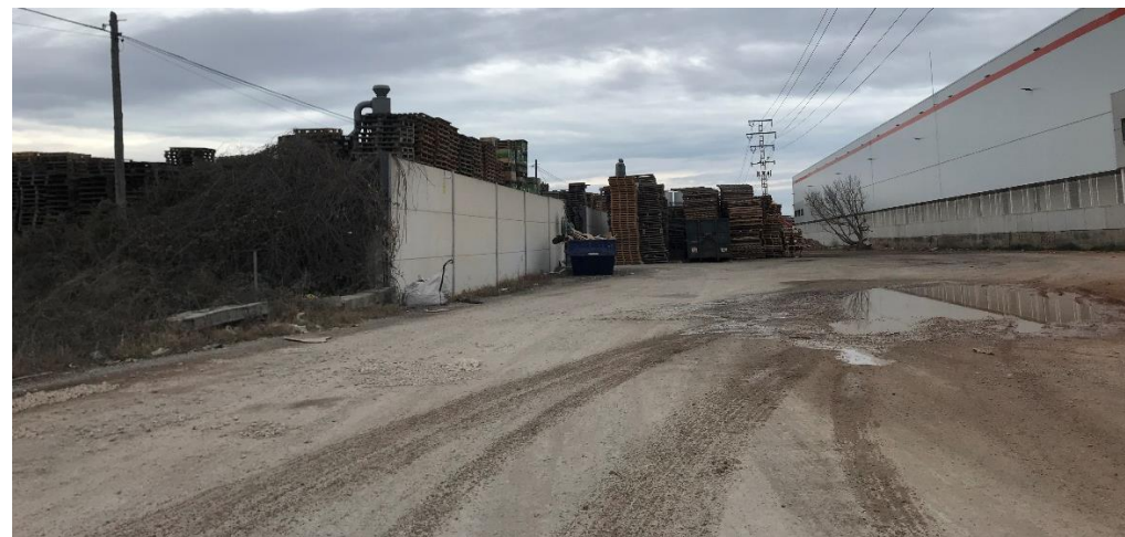
Figura 10. Estado de la carretera camí de la Canyada, cuenca N1
