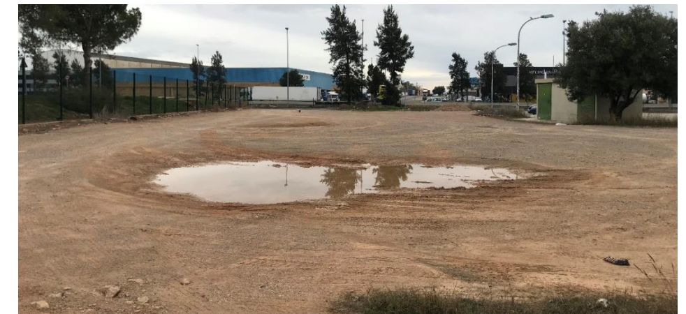
Figura 13. Estado de la zona verde en la calle Polígono 12, cuenca N1
