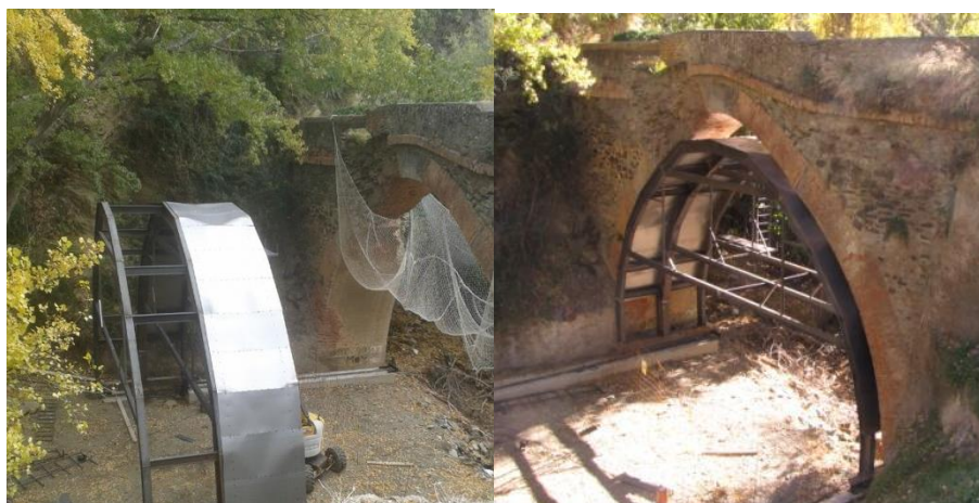
Fig. 5. Restauración del Puente de la Tableta. Fuente: Ayuntamiento de Válor.
