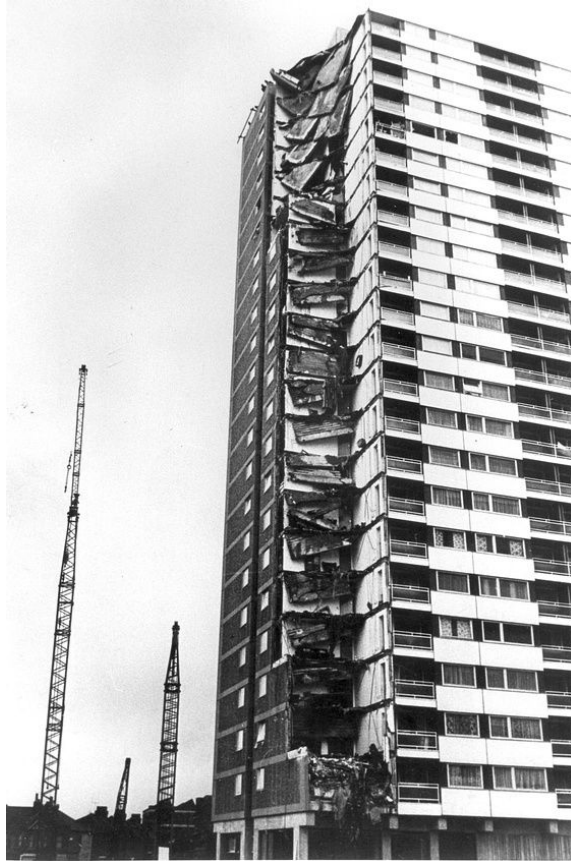
Ilustración 1. Edificio Ronan Point (Londres). Fuente: Newham photos.
