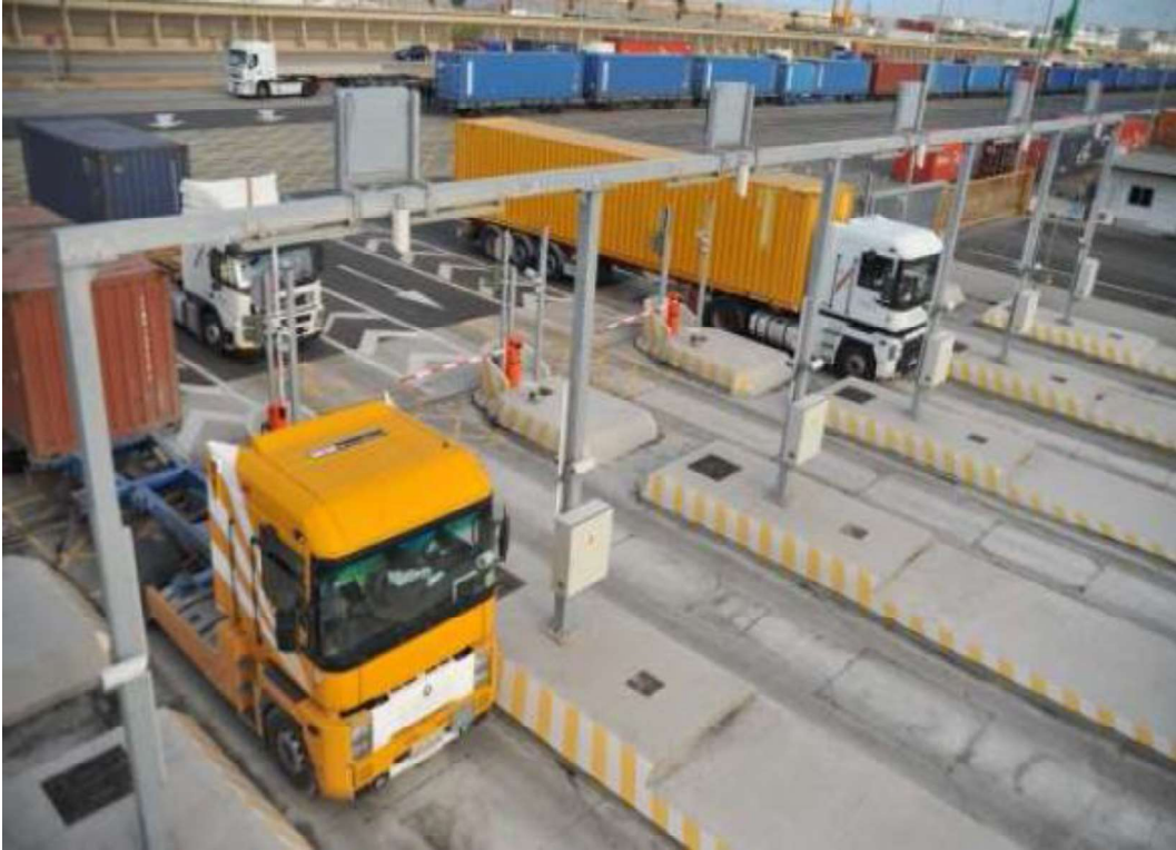
Imagen 8. Sistema automatizado en GATES. Fuente: Terminales Automatizadas y Semiautomatizadas. Operativa y equipamientos. Jaime Rodrigo de Larrucea
