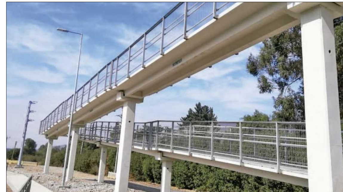
Figura 7-12: Pasarela ejecutada con vigas de hormigón prefabricado. (Fuente: https://discoveryprecast.com/noticias/uso-de-prefabricados-de-hormigon-en-pasarelas-peatonales/ )
