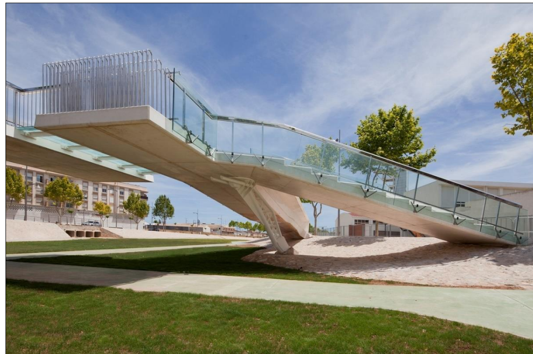
Figura 7-14: Pasarela "Kiss Bridge", de hormigón blanco ejecutada "in situ", en Pilar de la Horadada (Alicante). (Fuente: https://www.plazatio.com/es/proyecto/kiss-bridge-pasarela-peatonal-de-hormigon-blanco )
