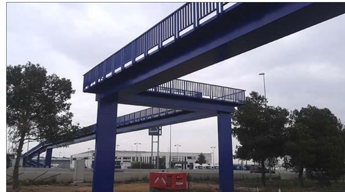
Figura 7-16: Pasarela de viga metálica. (Fuente: http://www.estructuraslinares.com/puentes-pasarelas/ )
