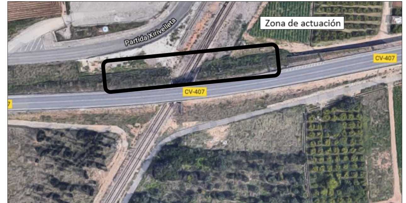
Figura 5-2: Zona de actuación. (Fuente: Google Maps)
