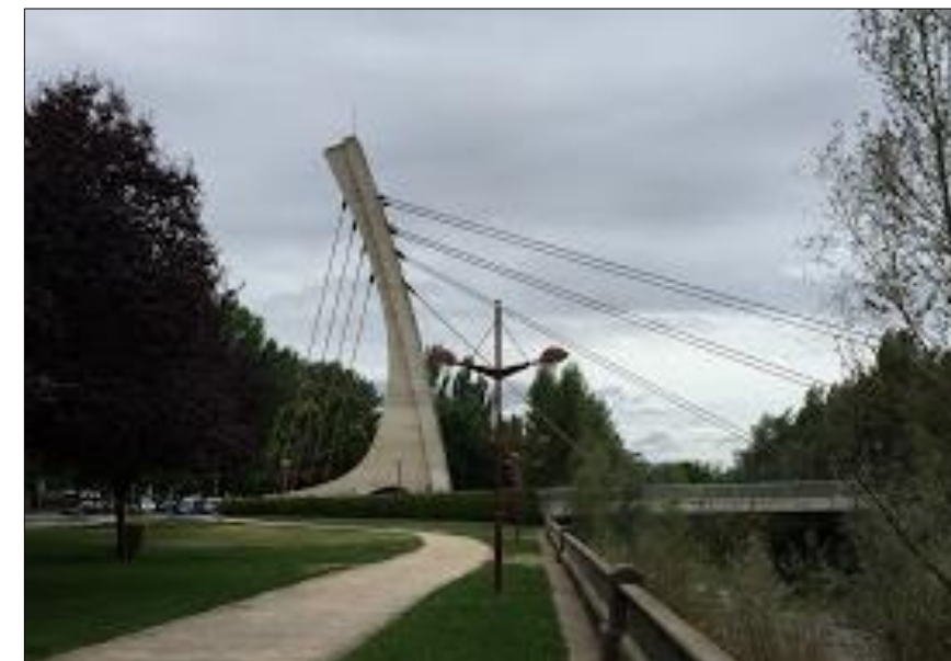
Figura 7-1: pasarela atirantada sobre el Río Bernesga en León. (Fuente: Google Imágenes)
