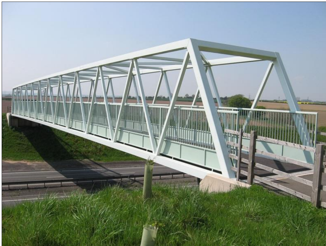
Figura 7-17: Pasarela de celosía metálica tipo Warren. (Fuente: https://www.estructurasmetalicascolombia.com/construcciones-metalicas/pasarelas-de-acero-y-puentes-peatonales )
