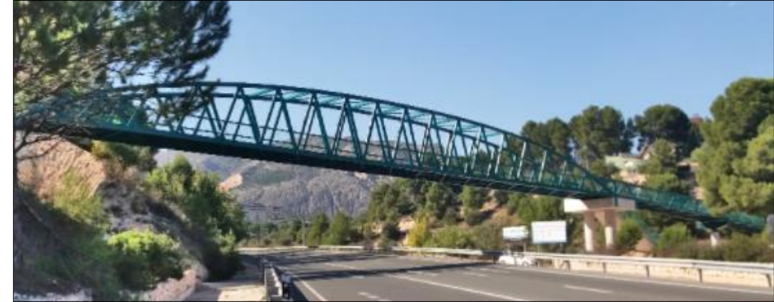
Figura 7-8: Pasarela en arco en Guerola. (Fuente: Google Maps)
