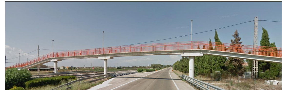
Figura 7-4: pasarela de la CV 500 de Pinedo. (Fuente: Google Imágenes)
