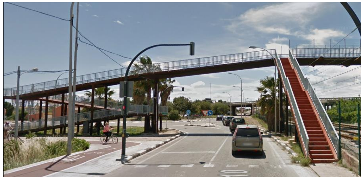
Figura 7-7: pasarela sobre la CV-5010. (Fuente: Google Maps)
