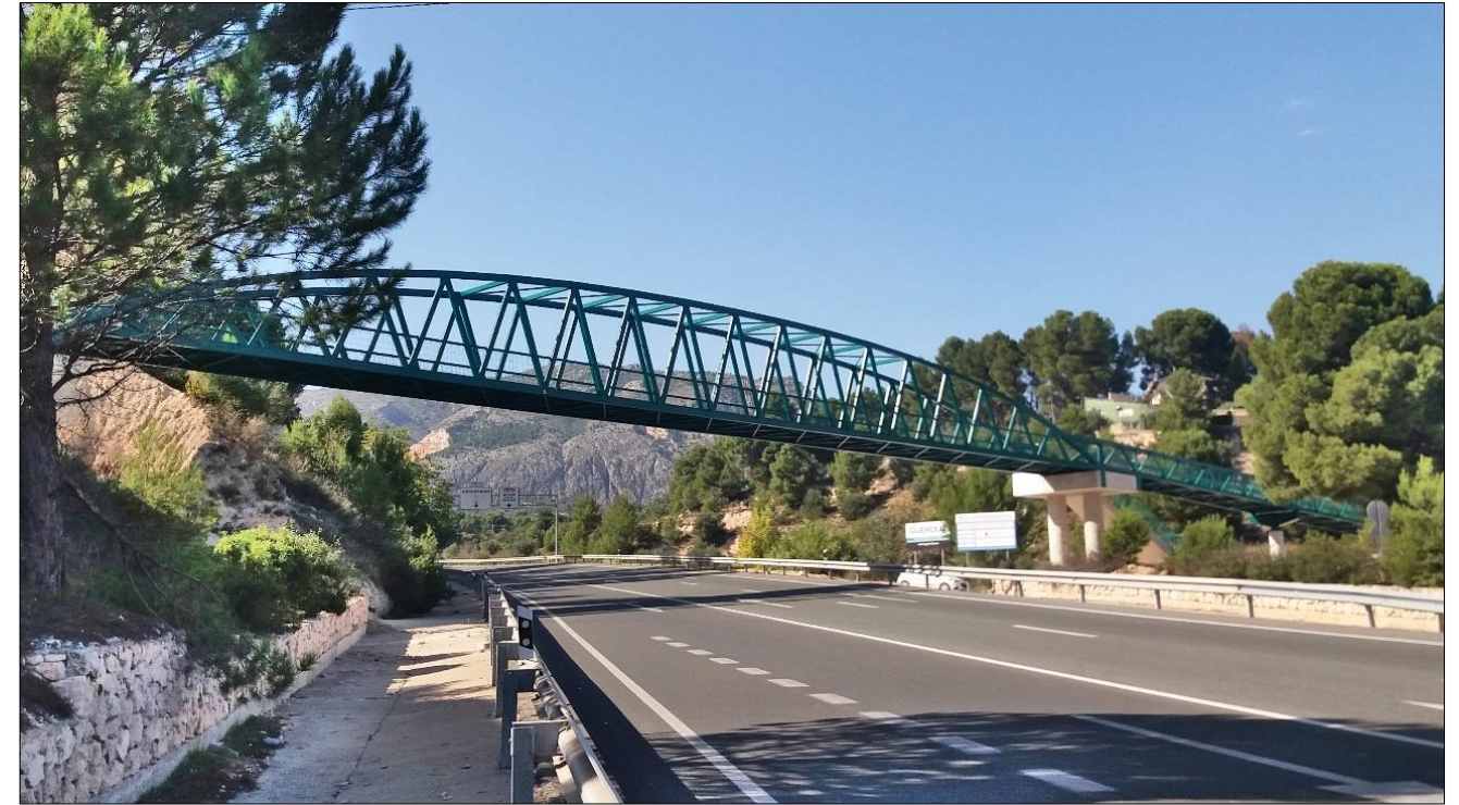
Figura 7-18: Pasarela peatonal metálica sobre la N-340 en Cocentaina (Alicante). (Fuente: https://guerola.es/project_category/carreteras )
