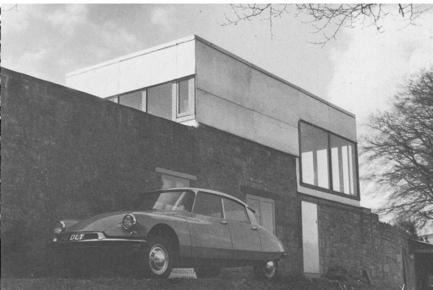
Así pues, Upper Lawn se genera como una caja de madera y vidrio, de no más de 80m<sup>2</sup>, apoyada sobre uno de los hastiales recuperados, por su buen estado, de la preexistencia y que ahora pasa a ser el centro de la nueva vivienda. Por otra parte, el pabellón construido
