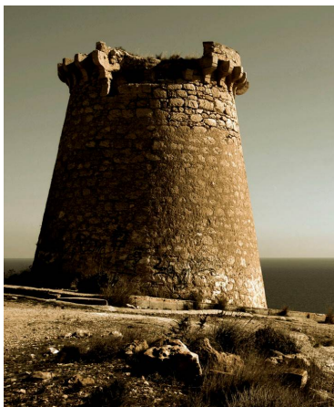
Torre de Escaletes (Santa Pola)
