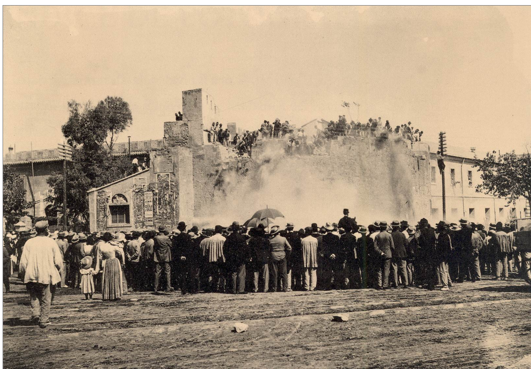
Derribo del torreón de la Ciudadela. J. Martínez Aloy. 1901. Valencia 1900. El legado fotográfico de J. Martínez Aloy 71
