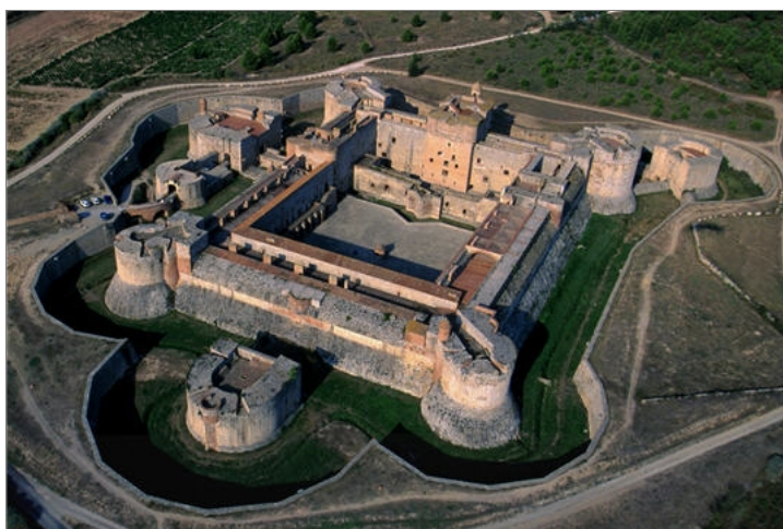
Vista aérea de la Fortaleza de Salsas
