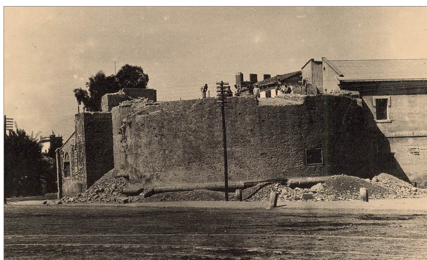
Derribo del torreón de la Ciudadela. J. Martínez Aloy. 1901. Valencia 1900. El legado fotográfico de J. Martínez Aloy
