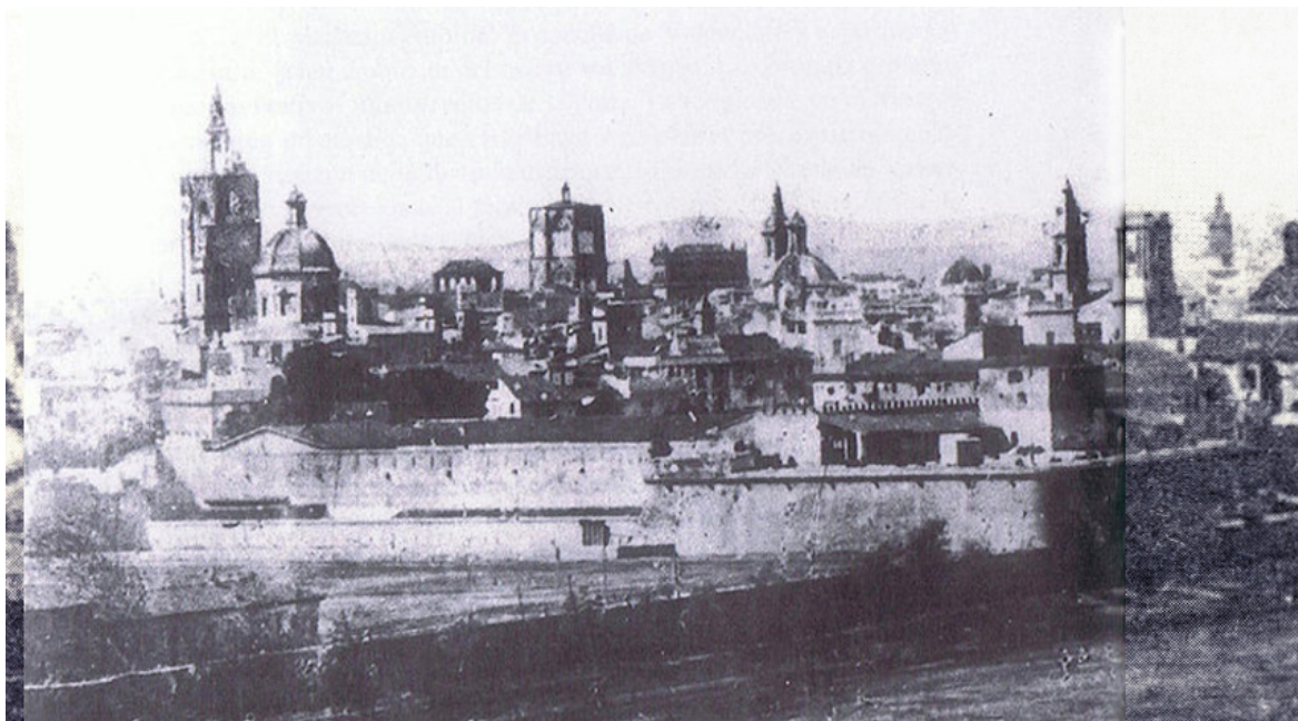
En la parte derecha de la imagen se puede apreciar con claridad sobre el baluarte, el prisma de la torre de L' Esperó. Vista desde la Alameda. 1960 Ca.
