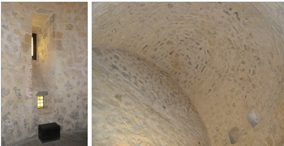
Hueco para el tiro y bóveda de horno de mampostería en una de las torres del Alcázar de Segovia. Fotografías del autor
