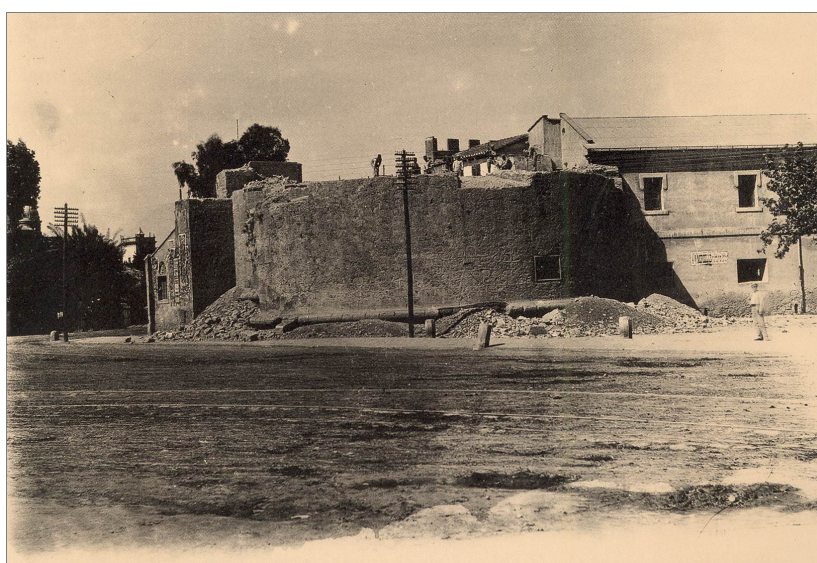
Derribo del torreón de la Ciudadela. J. Martínez Aloy. 1901. Valencia 1900. El legado fotográfico de J. Martínez Aloy
