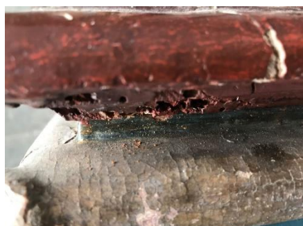
Fig.17: Detalle del ataque de insectos xilófagos.
