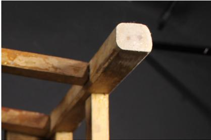
Fig 9. Ejemplo de humedad en una de las patas
