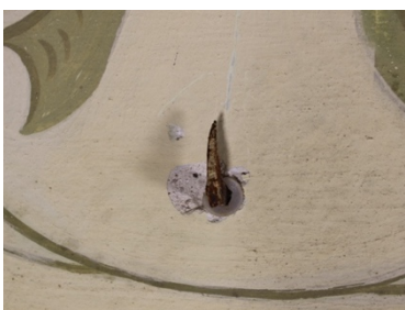
Fig.52: Escarpia de hierro oxidada
