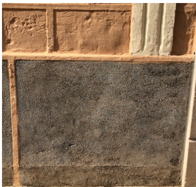
Fig.8: Detalle del zócalo de la fachada
