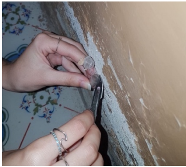
Fig.64: Extrayendo sales del zócalo, pared norte
