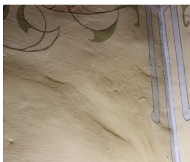
Fig.56: Abolsamientos pared sur
