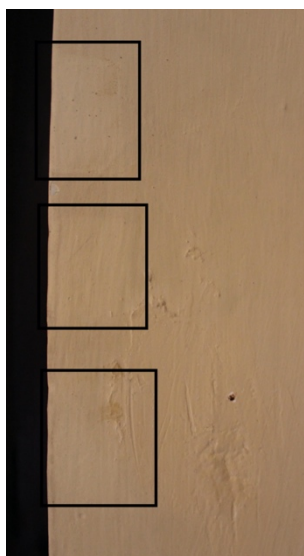
Fig.74: Catas de limpieza
