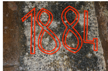
Fig.7: Detalle del suelo con la fecha de la construcción marcada
