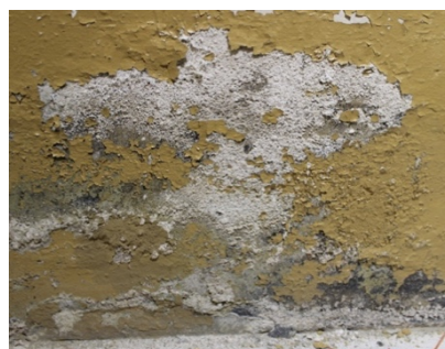
Fig.62: Zócalo afectado por sales
