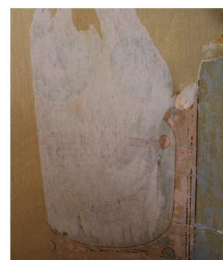
Fig.83: Papel eliminado de la pared
