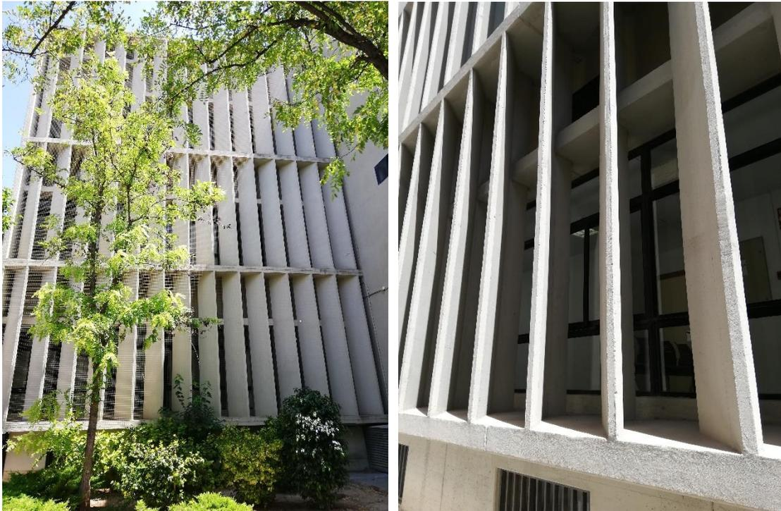
figs. 92 y 93: Fachada Sur. Detalle de la protección solar. Fotografías desde el interior del recinto
