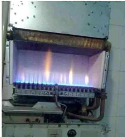
*Figura 8. Quemador atmosférico (Combustión\_Teoría\_Calderas, s. f.)*
