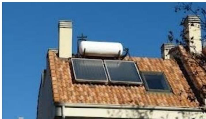
Figura 17. Sistema solar con termosifón (Instalaciones Termosolares para la Producción de Agua Caliente Sanitaria (ACS), s. f.)
