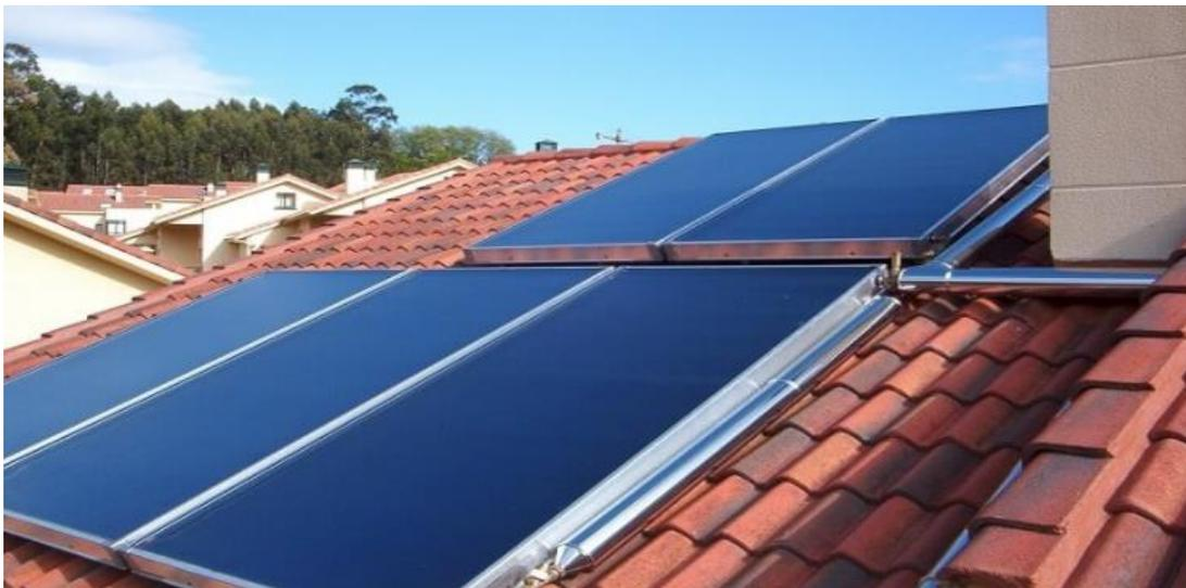
*Figura 14. Instalación fototérmica (Cómo funciona la energía solar térmica, s. f.)*
