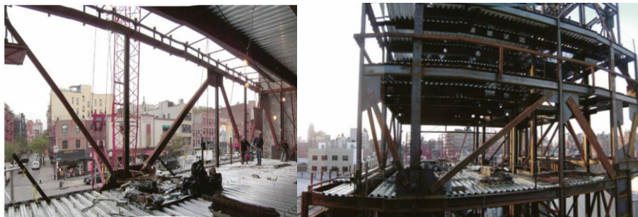
Figura 26. Detalle de la construcción de la estructura perimetral de acero. (Arango, 2013)
