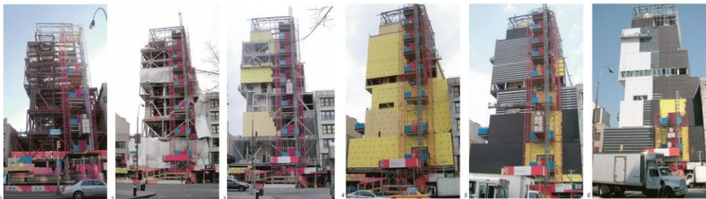
Figura 30. Fases del proceso constructivo del Museo. (Arango, 2013)
