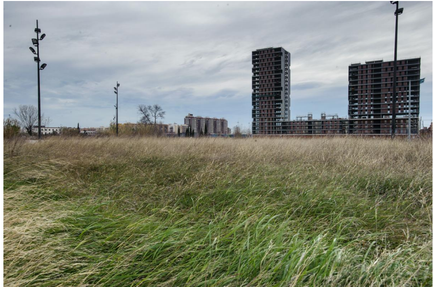
Edificio inacabado y solar sin edificar en Sociópolis, 2014.
