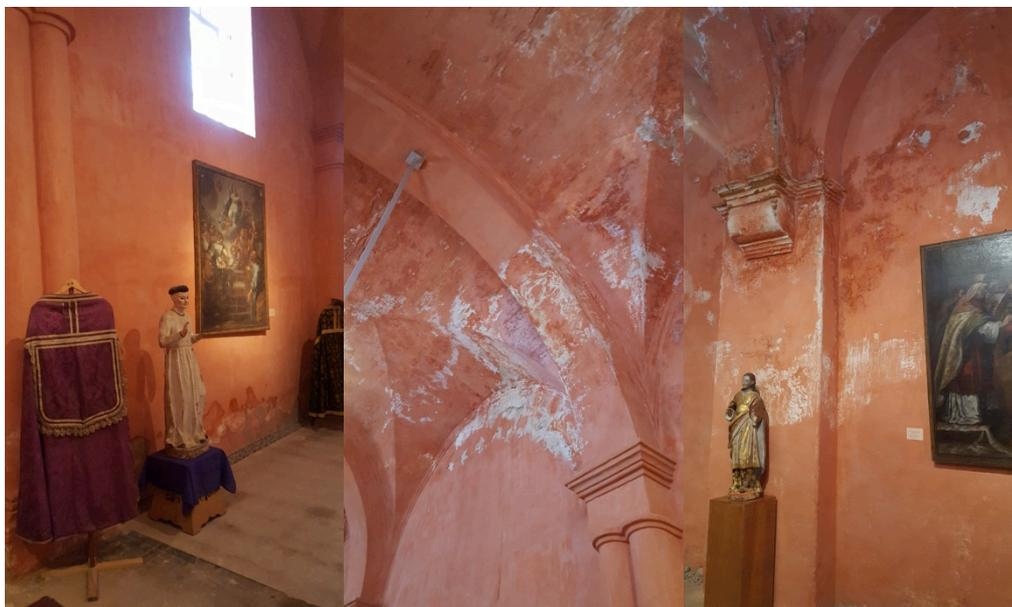
*Imagen 32 - Detalle de los problemas de humedad presentes en la estructura del edificio (abril de 2019).*
