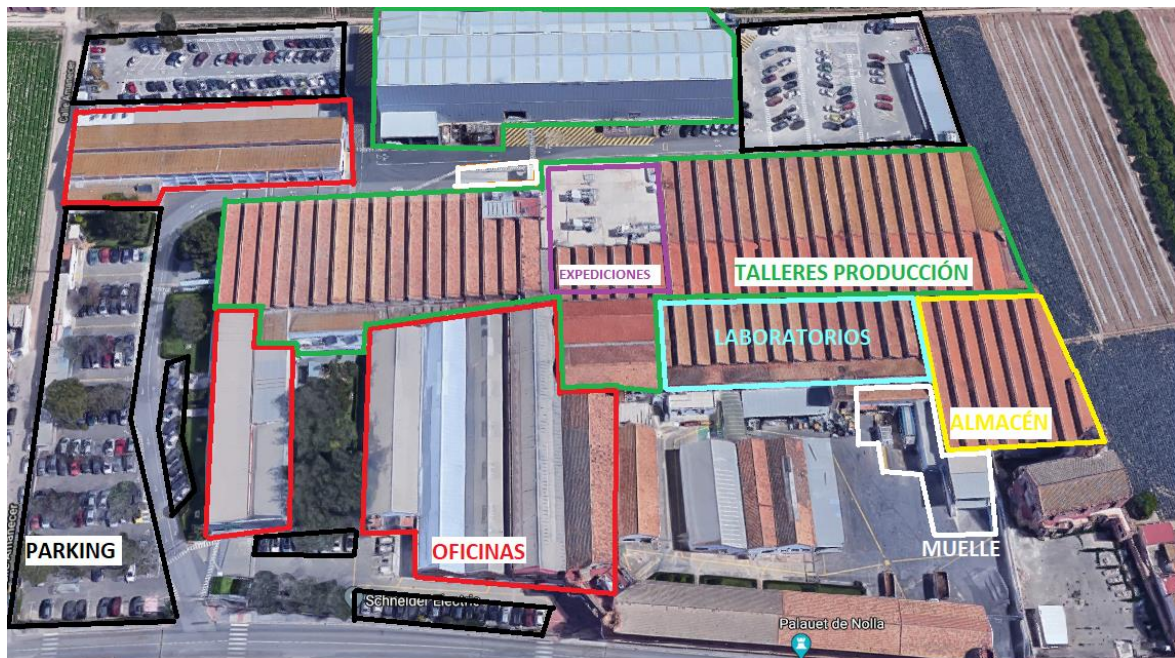
Ilustración 6: Planta Schneider Electric Meliana. Fuente: Schneider Electric Meliana
