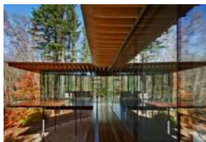
Fig. 216. Kengo Kuma, Casa di vetro e legno , New Canaan, Connecticut, 2011
