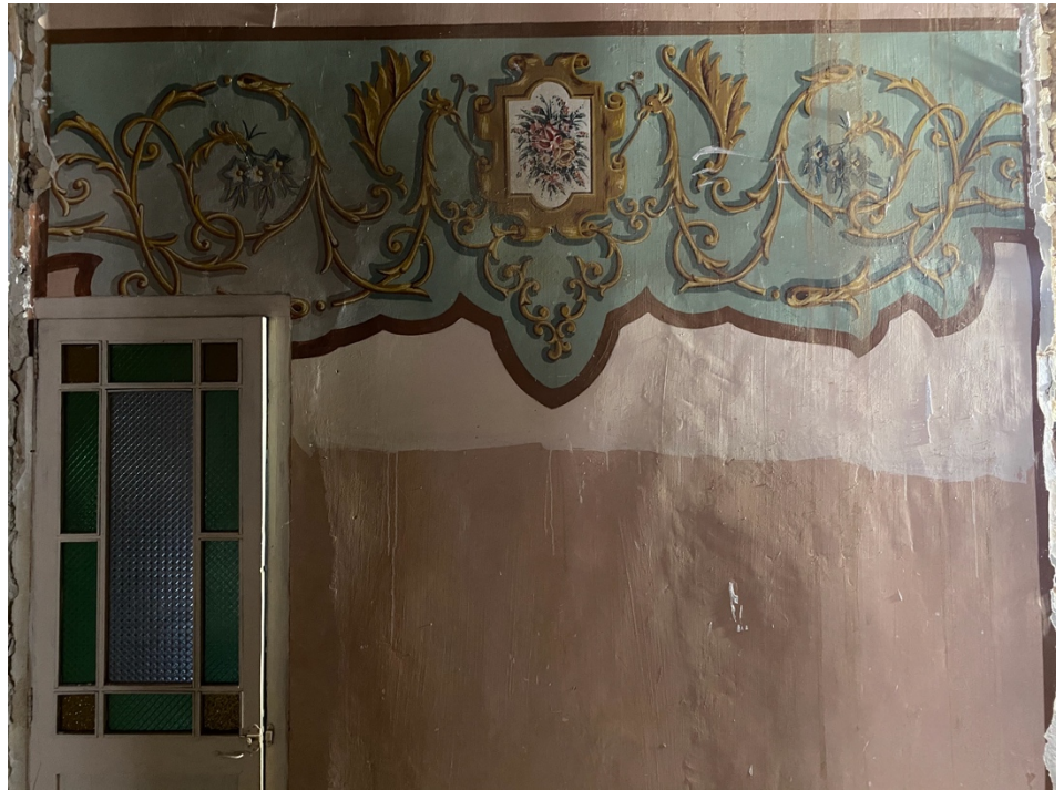
Img.42: Fotografía rasante de la obra mural, muestra las irregularidades de la misma.
