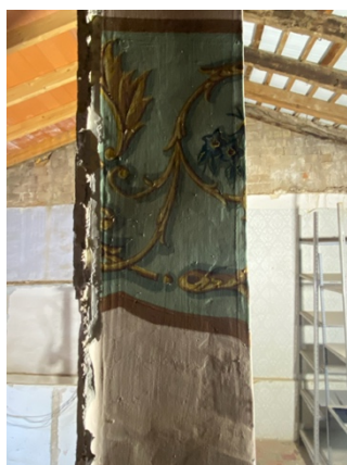
Img.55: Fotografía rasante de la cenefa sobre el costado oeste del pilar de carga, muestra las huellas de las pinceladas en la técnica.
