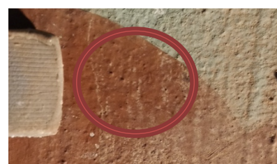
Img.64: Resultado de la cata de limpieza mecánica con goma maleable.
