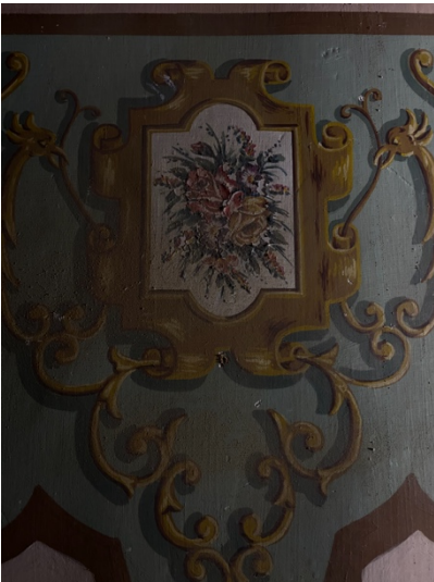
Img.46: Fotografía rasante de la representación central, muestra escamas y pérdidas pictóricas.
