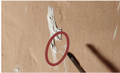
Img.65: Resultado de la cata de limpieza mecánica con bisturí.
