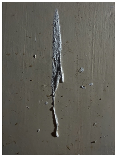
Img.50: Fotografía detalle en rasante de una de las concreciones de escayola.
