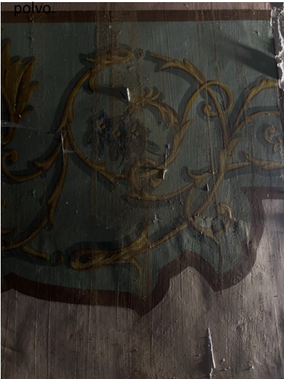
Img.44: Fotografía rasante del sector con escorrentías, muestra la película de polvo y concreciones de escayola.
