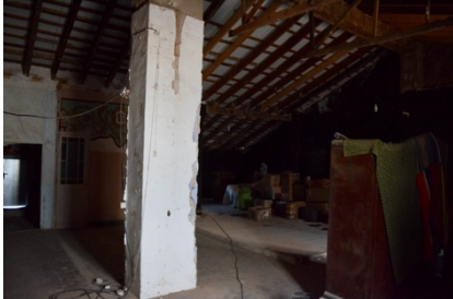
Img. 14: Visión general hacia el interior del primer piso de la vivienda.
