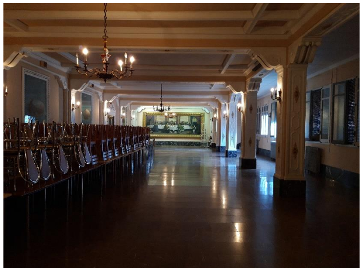
Figura 64. Comedor al comienzo de la intervención de 2019. Perspectiva de la obra desde una de las entradas cercana a la zona de servicio/cocina.
