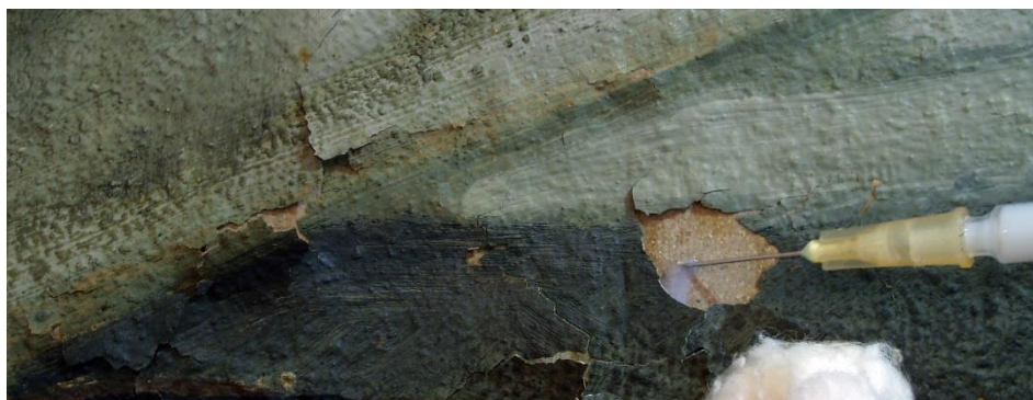
Figura 48. Aplicación del material consolidante (Acril™ 33 al 15% en agua destilada).
