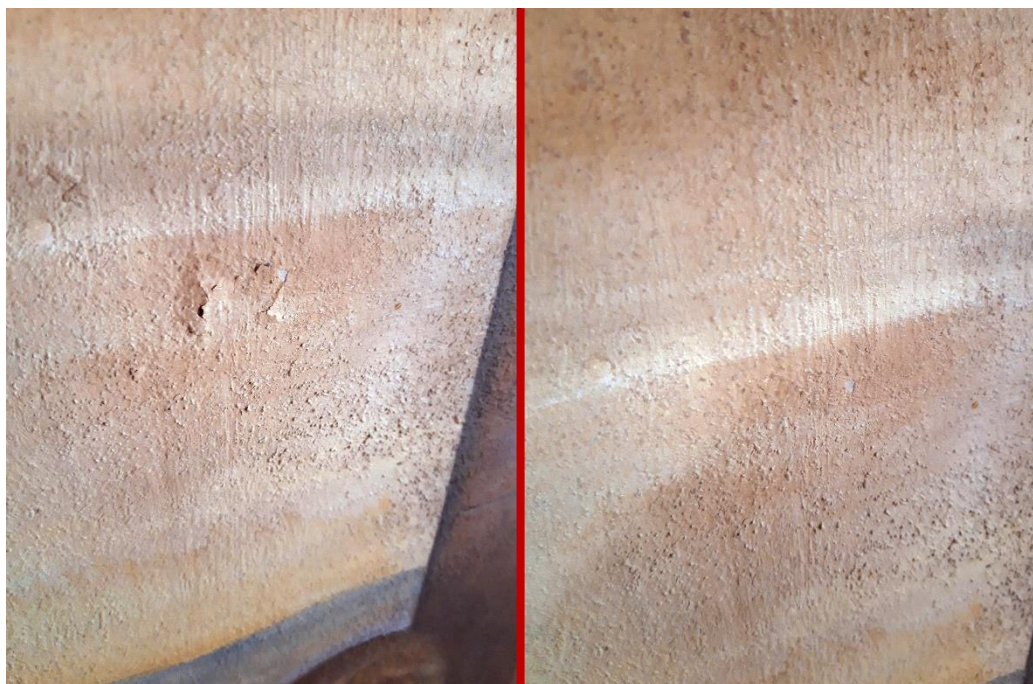
Figura 54. Comparación. Estado previo y posterior a la consolidación y recolocación de la pintura de vuelta a su lugar.
