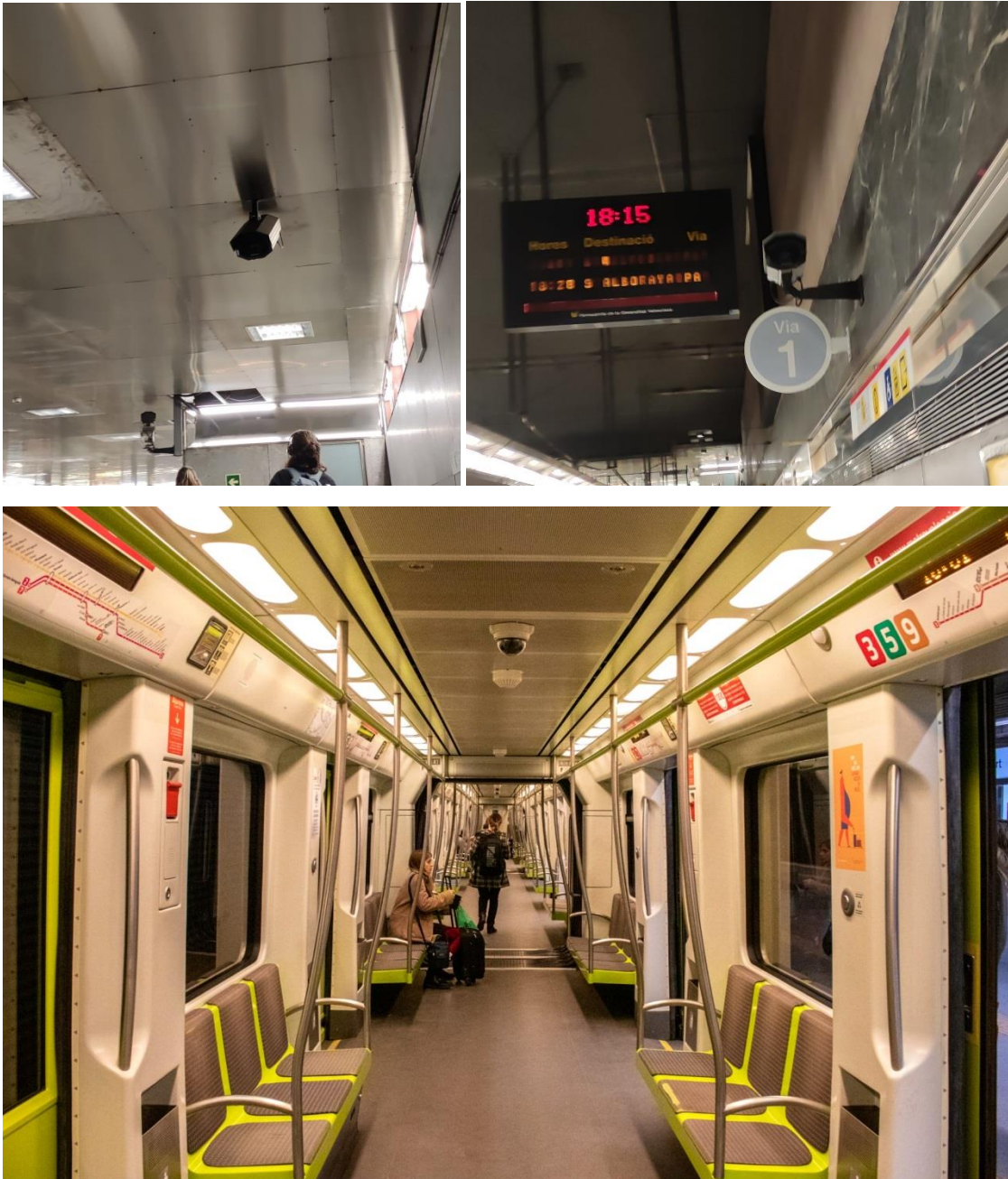
Ilustración 21 – Cámaras de videovigilancia estación y coche, respectivamente, en Metrovalencia.. Fuente: elaboración propia.
