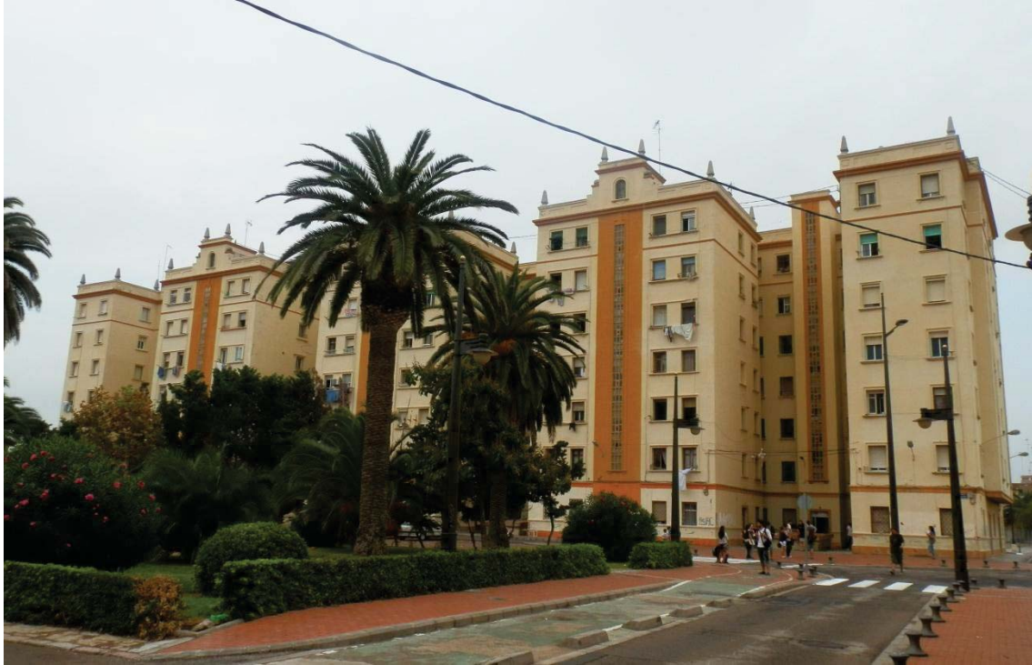
Imatge 4.12. Façana principal del Bloc d'habitatges Ruiz Jarabo, vista des del C\ dels Pescadors.
