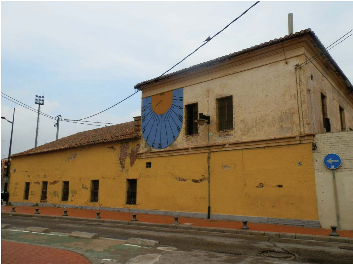
Imatge 4.7. Façana sud de la Casa dels Bous, al C\ dels Pescadors.
