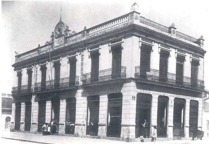
Imatge 3.2.22. El Casinet del Progreso Pescador.
