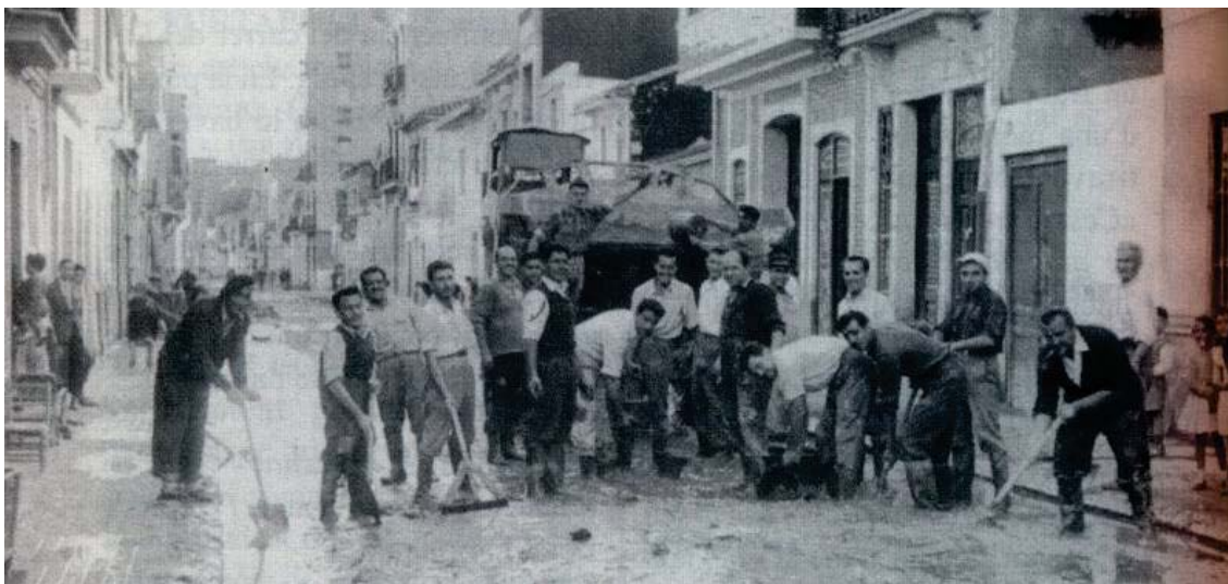
Imatge 3.2.27. Després de la riuada del 1.957. Carrer P. L. Navarro, entre C\ Columbretes i C\ Amparo Guillem.
