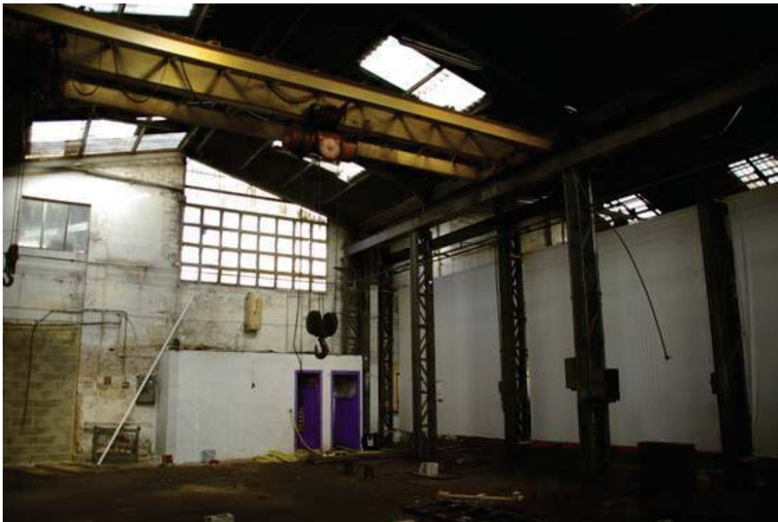
Imatge 4.11. Interior de la Fàbrica de Gel.
