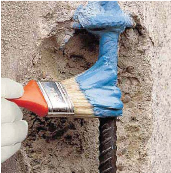
Imatge 8.1. Aplicació de passivant a una armadura.
