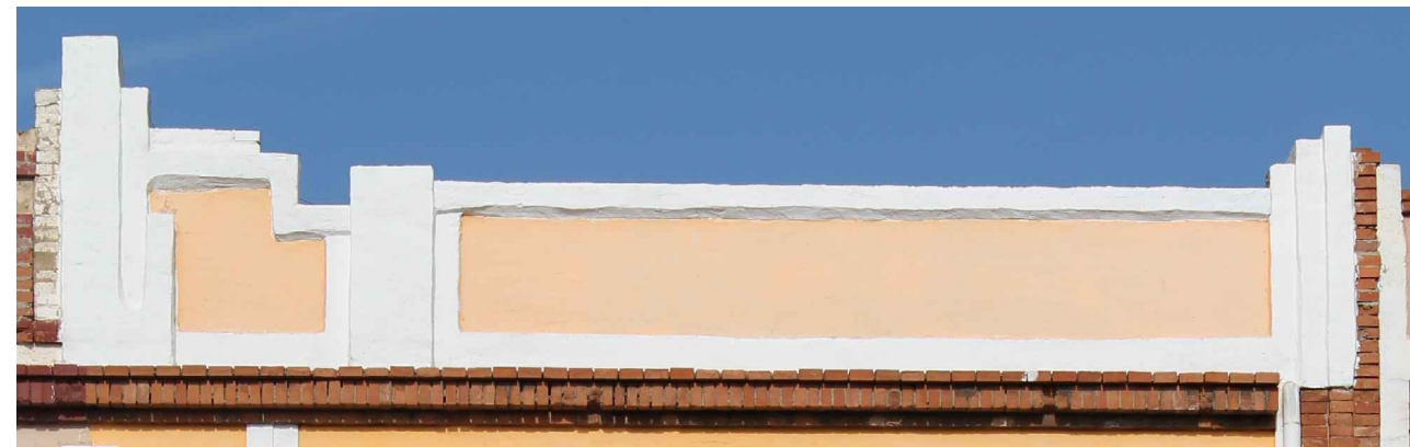
Imatge 7.2.1. Ampit casa veïna (nº56B). S'ha utilitzat per a veure la composició de l'ampit.
