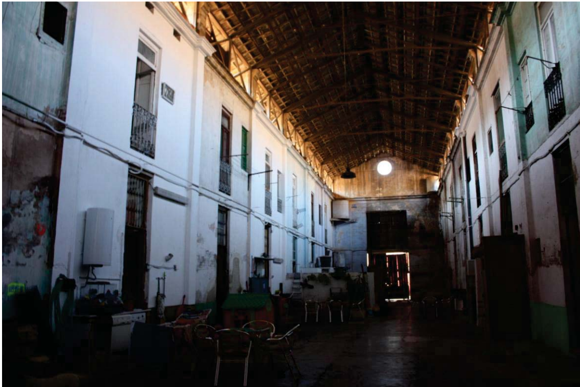
Imatge 4.5. Interior de la nau central de la Llotja del Peix.
