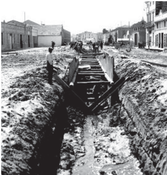
Imatge 3.2.9. Obres de clavegueram.
