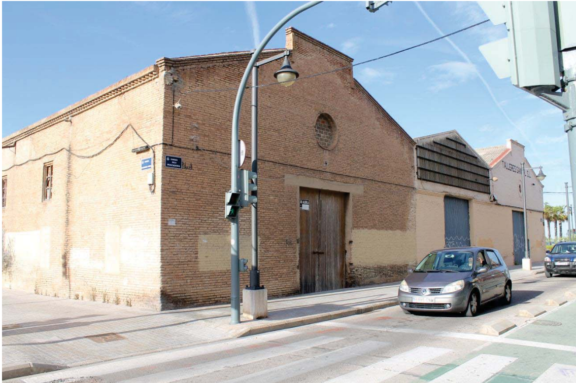
Imatge 4.10. Façana sud de la Fàbrica de Gel, C\ dels Pescadors.
