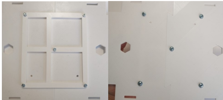
Ilustración 49 Atornillado del refuerzo inferior.
