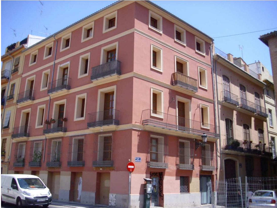
Imagen nº 90. Edificio rehabilitado en la Pza. de la comunión de San Juan. Junio 2012
