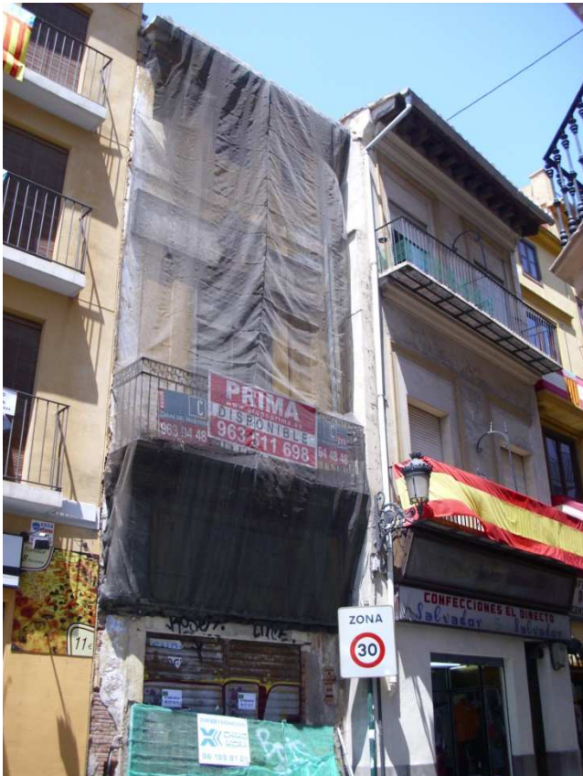
Imagen nº 26. Edificio en mal estado de conservación en c/ Bolsería. Junio 2012.
