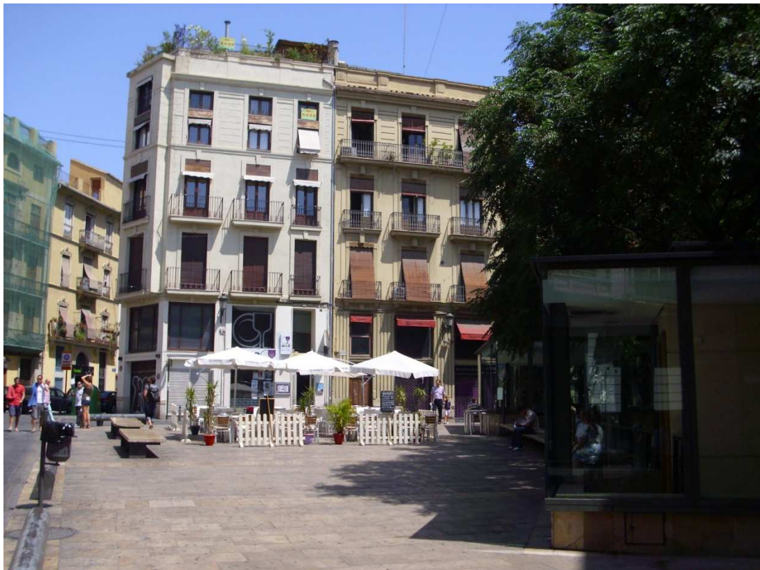
Imagen nº 87. Edificios rehabilitados en la Pza. del Tossal. Junio 2012.
