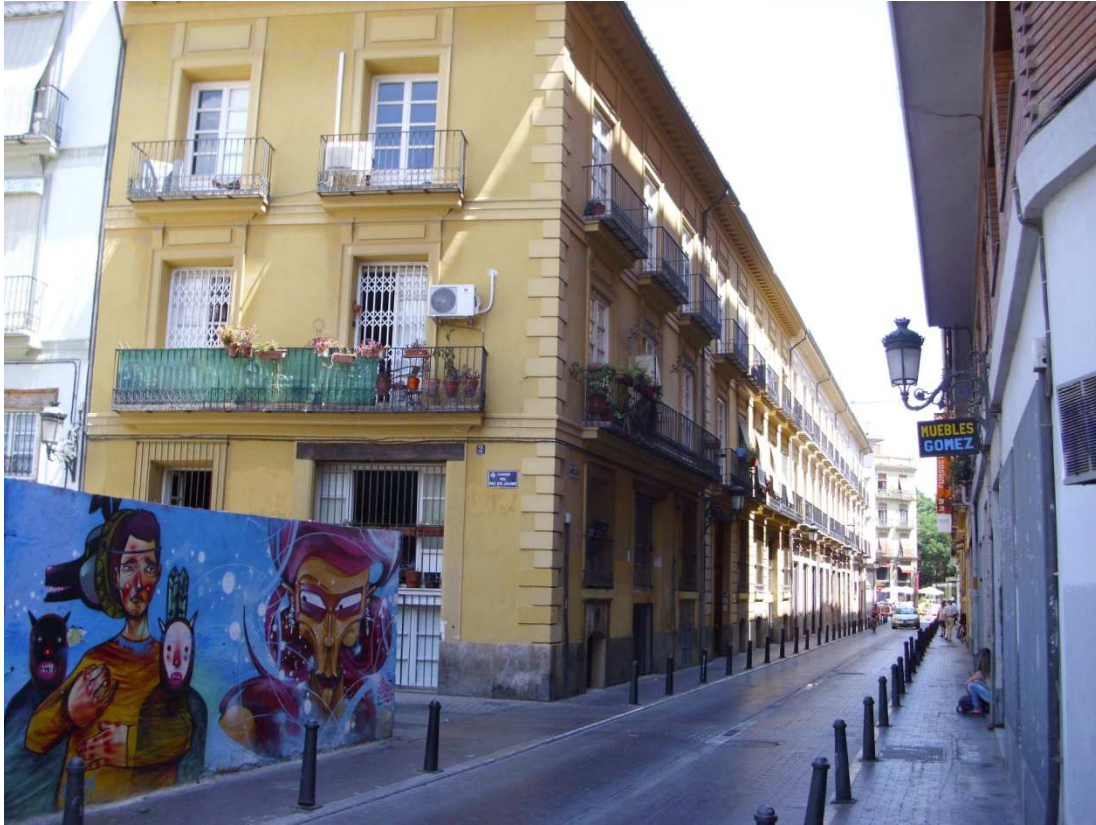
Imagen nº 84. Edificios rehabilitados en la c/ Moro Zeit. Junio 2012.
