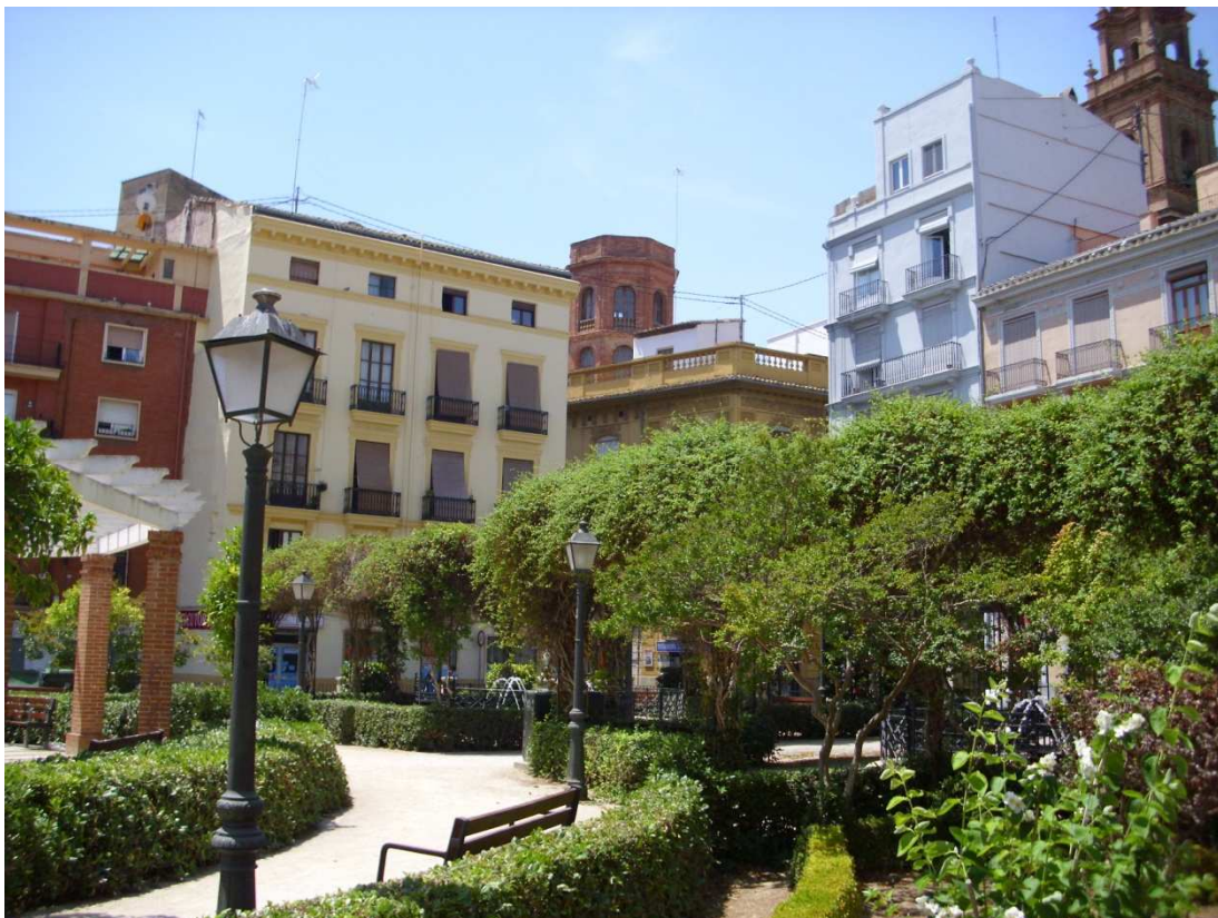
Imagen nº 91. Edificios rehabilitados en c/ de Carniceros y c/ de Sta. Teresa. Junio 2012.
