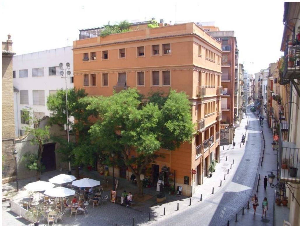
Imagen nº 77. Edificio rehabilitado en c/ de Quart con Pza. Santa Úrsula. Vista desde las Torres de Quart. Junio 2012.
