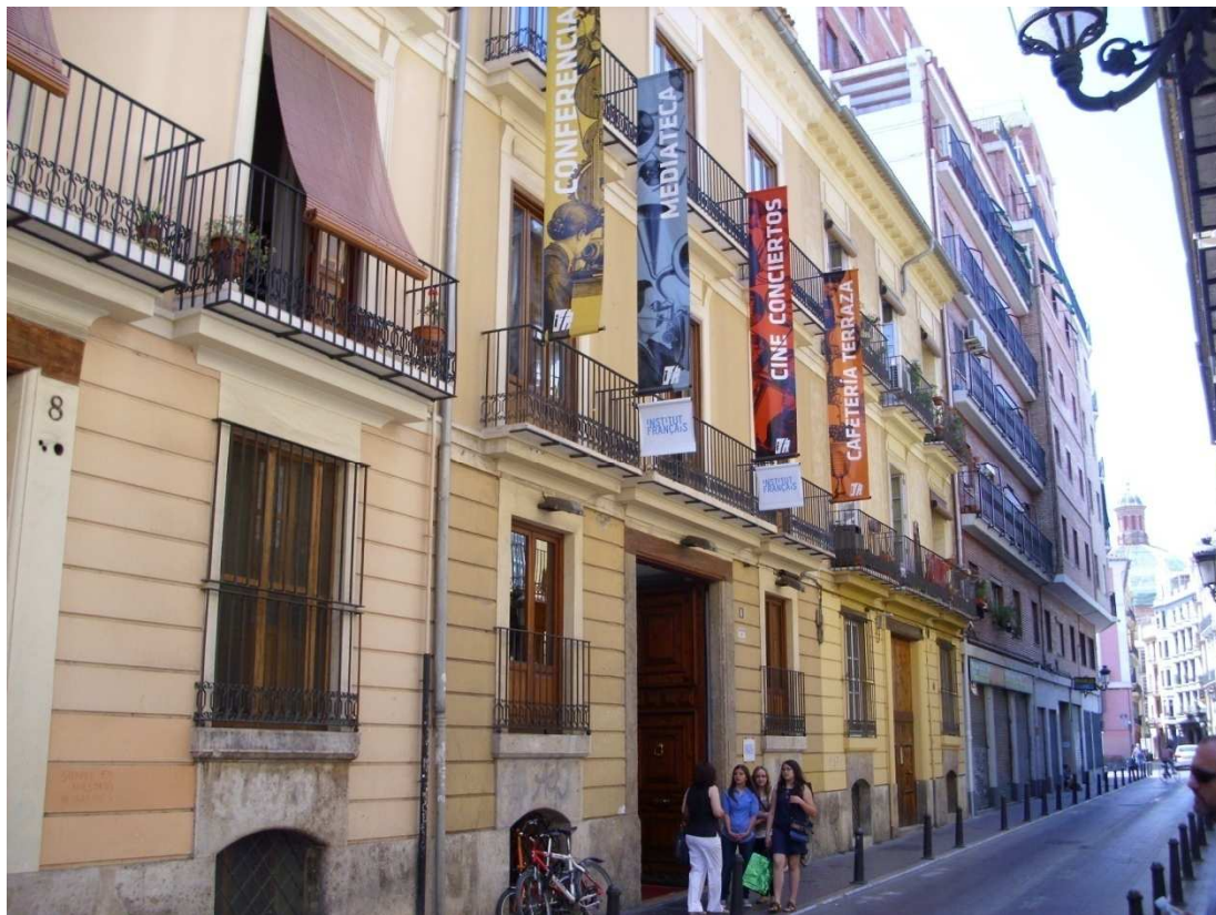
Imagen nº 85. Edificios rehabilitados en la c/ Guillem de Sorolla. Junio 2012.
