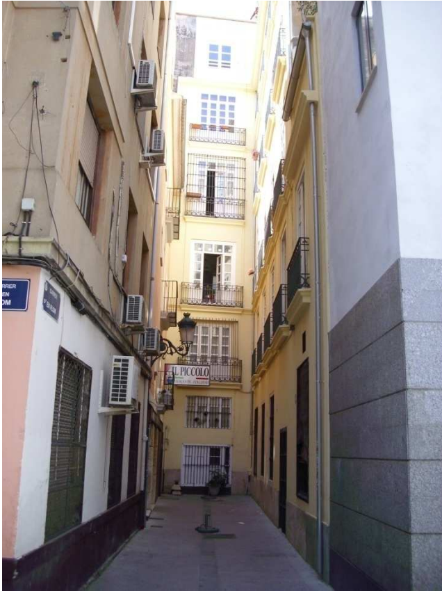
Imagen nº 76. Edificio rehabilitado en esquina c/ en Plom. Junio 2012.
