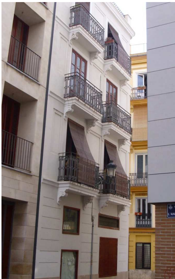
Imagen nº 73. Edificio rehabilitado en c/ de Recared. Junio 2012.
