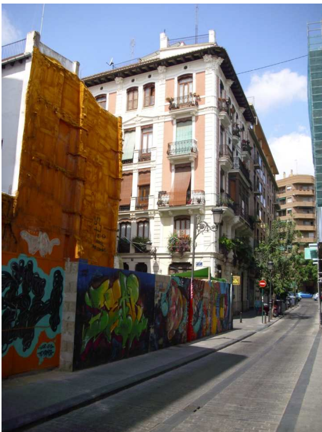
Imagen nº 75. Edificio rehabilitado en esquina c/ Lope de Rueda con c/ Pintor Domingo. Junio 2012.
