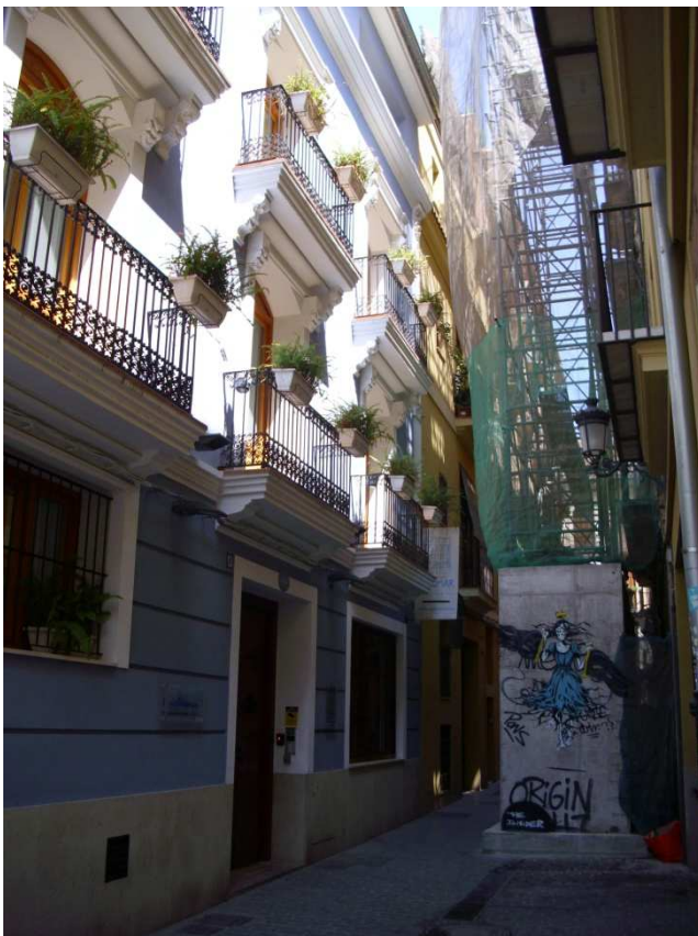
Imagen nº 83. Edificio rehabilitado en c/ Palomar. Junio 2012.
