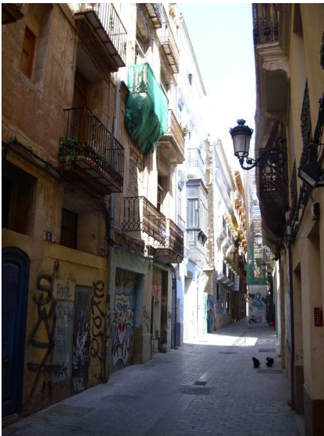
Imagen nº 24. Varios edificios en mal estado de conservación en c/ Palomar. Junio 2012.
