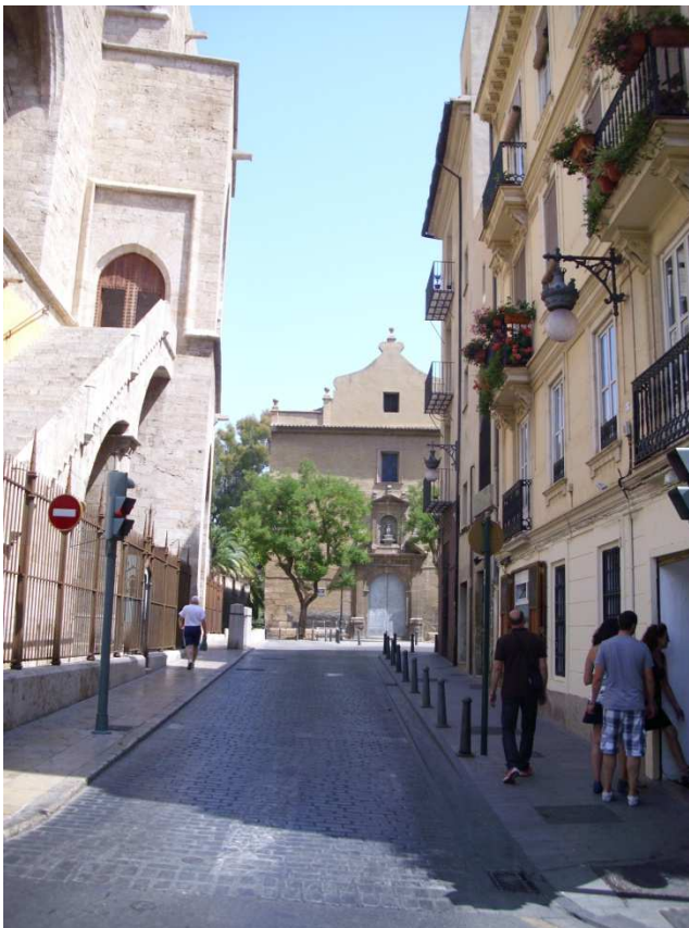
Imagen nº 79. Edificios rehabilitados en la c/ de Guillem de Castro, detrás de las Torres de Quart. Vista desde las Torres de Quart. Junio 2012.
