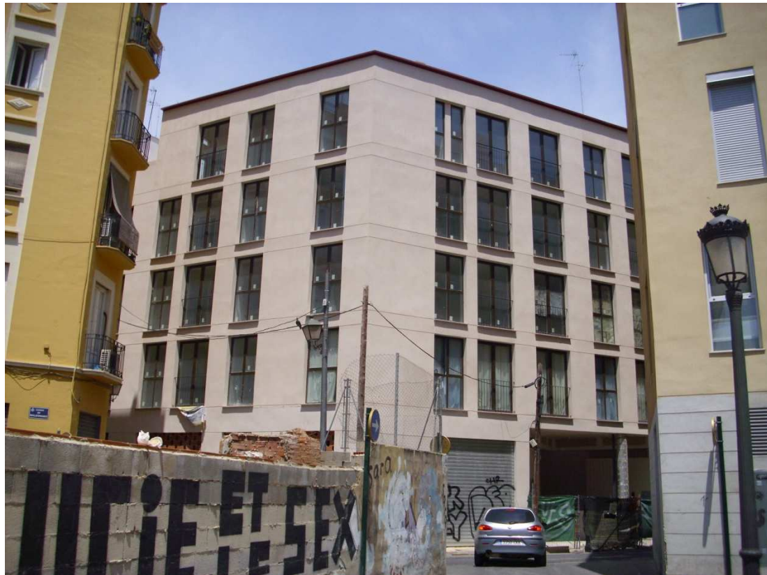
Imagen nº 46. Edificio de nueva planta en esquina c/ de Maldonado con c/ del Bany. Junio 2012.
