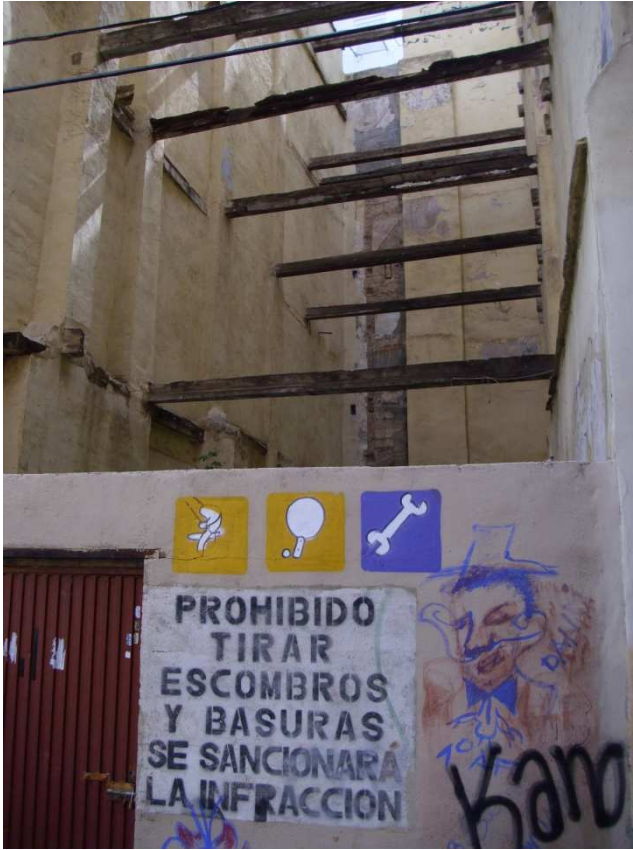
Imagen nº 48. Solar entre medianeras en la c/ Torn de l, Hospital. Junio 2012.
