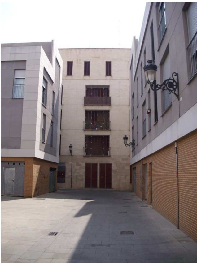
Imagen nº 32. Edificio de nueva planta de promoción pública en c/ Torn de l'Hospital en su encuentro con c/ d' Angelicot. Junio 2012.
