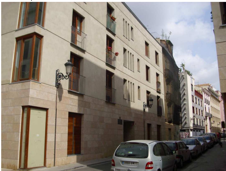
Imagen nº 30. Edificio de nueva planta en c/ Recared nº24.
