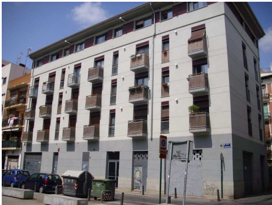
Imagen nº 11. Edificio residencial de nueva planta en c/ Arolas. Junio 2012.
