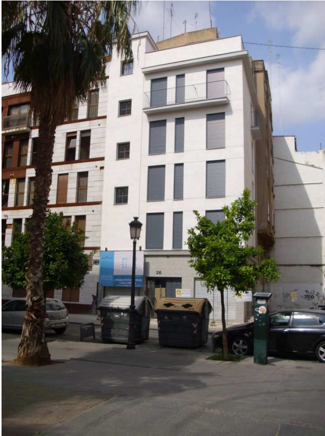
Imagen nº 31. Edificio VPO de nueva planta de promoción pública en c/ Recaredo esquina con c/ Roger de Flor. Junio 2012.
