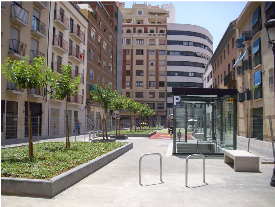
Imagen nº 94. Acceso peatonal en obras al nuevo parking subterráneo en c/ de Vinatea. Junio 2012.
