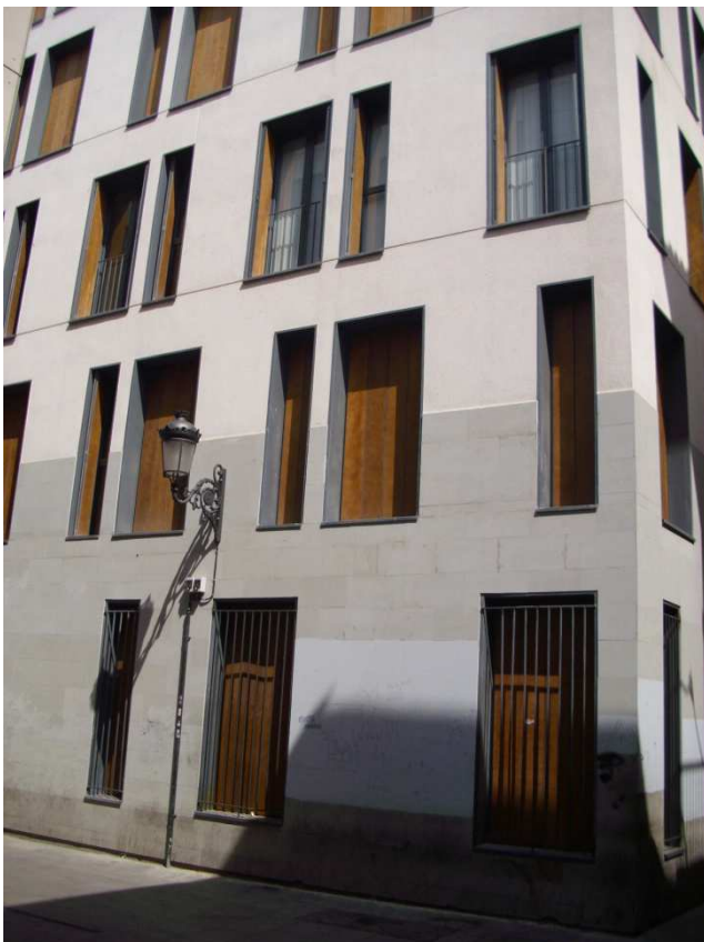
Imagen nº 36. Edificio de nueva planta en c/ Torn de l'Hospital esquina con c/ de Viana. Junio 2012.
