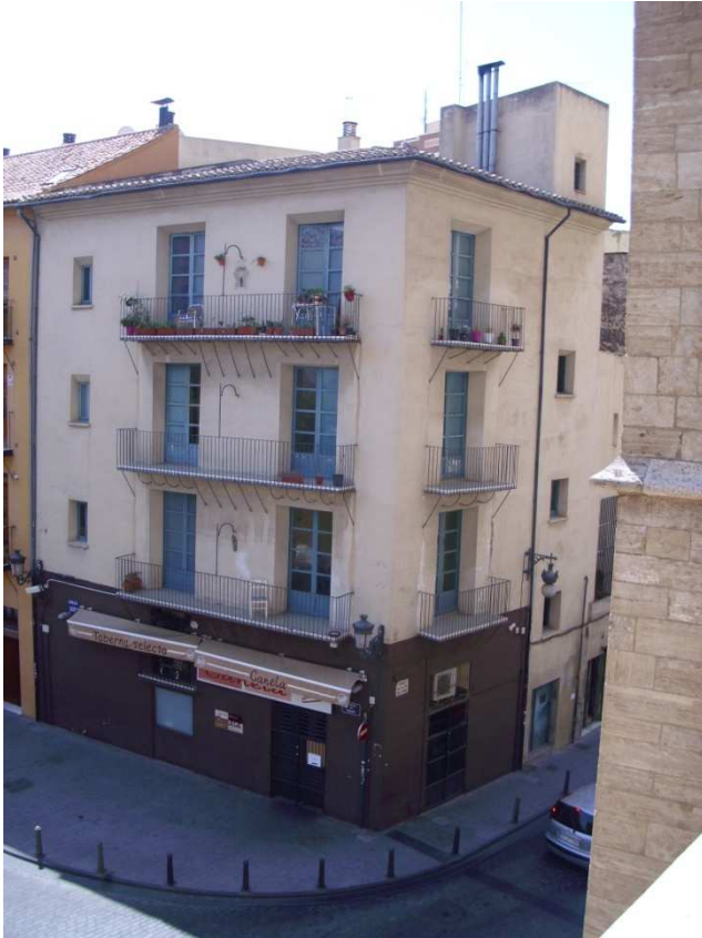
Imagen nº 80. Edificio rehabilitado en esquina de la c/ de Quart con c/ Guillem de Castro. Vista desde las Torres de Quart. Junio 2012.
