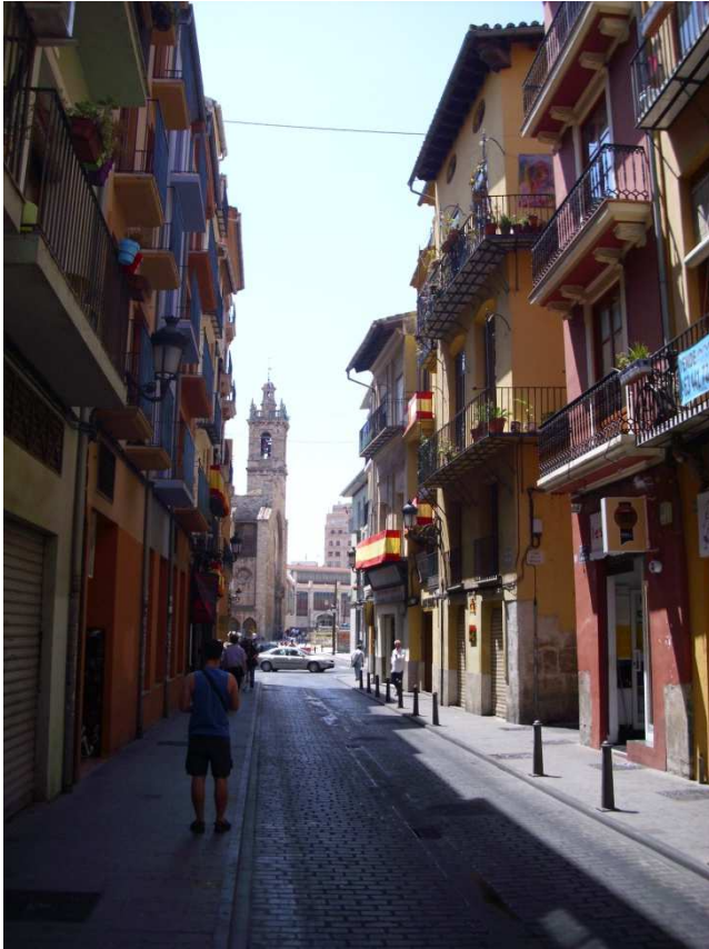
Imagen nº 88. Edificios rehabilitados en c/ Bolsería. Junio 2012.
