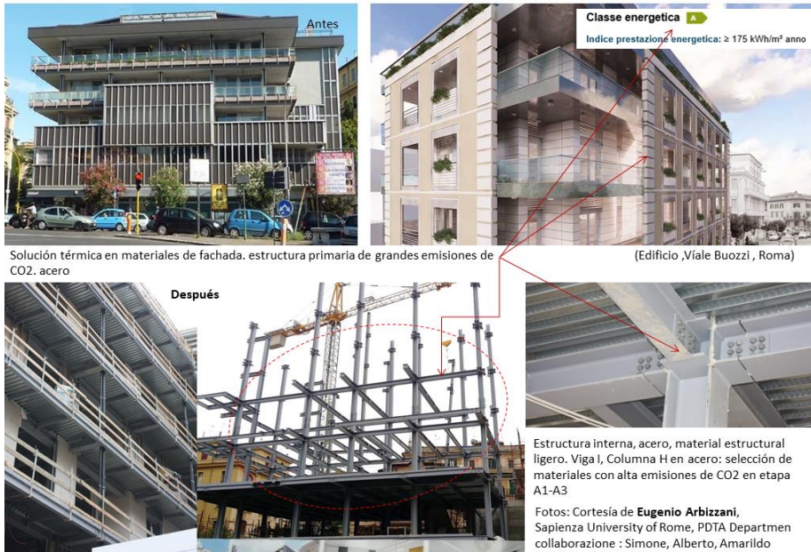
Panel 1.18. Fotos, cortesía de Arq. Eugenio Arbizzani, Caso de edificio, fachada contemporánea nueva obra, fachada rehabilitada de manera total, Edificio, Viale Boozzi, Roma. –Análisis de materiales y tecnología estructural, Corso in Architettura: riqualificazione architettonica e tecnologica dell’edilizia.
