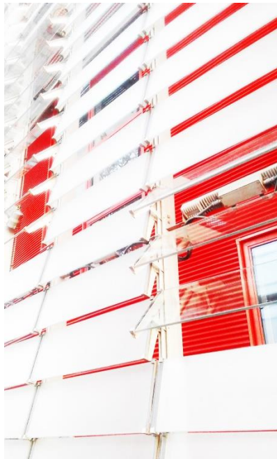
Imagen 1.4 -Caso 4. Foto. César Arguedas; Alta energía embebida. Detalle de fachada en vidrio. Uso de Vidrio, hormigón, estructura de piel metálica, aluminio (materiales de altas emisiones de CO2), caso de fachada de gran eficiencia bioclimática- estrategias pasivas, pero con grandes emisiones durante el proceso industrial de la producción de los materiales primarios utilizados. Torre Agbar, Arq. Jean Nouvel. Barcelona, España.
