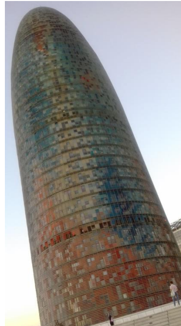
Imagen 1.4 -Caso 4. Foto. César Arguedas; Alta energía embebida. Detalle de fachada en vidrio. Uso de Vidrio, hormigón, estructura de piel metálica, aluminio (materiales de altas emisiones de CO2), caso de fachada de gran eficiencia bioclimática- estrategias pasivas, pero con grandes emisiones durante el proceso industrial de la producción de los materiales primarios utilizados. Torre Agbar, Arq. Jean Nouvel. Barcelona, España.
