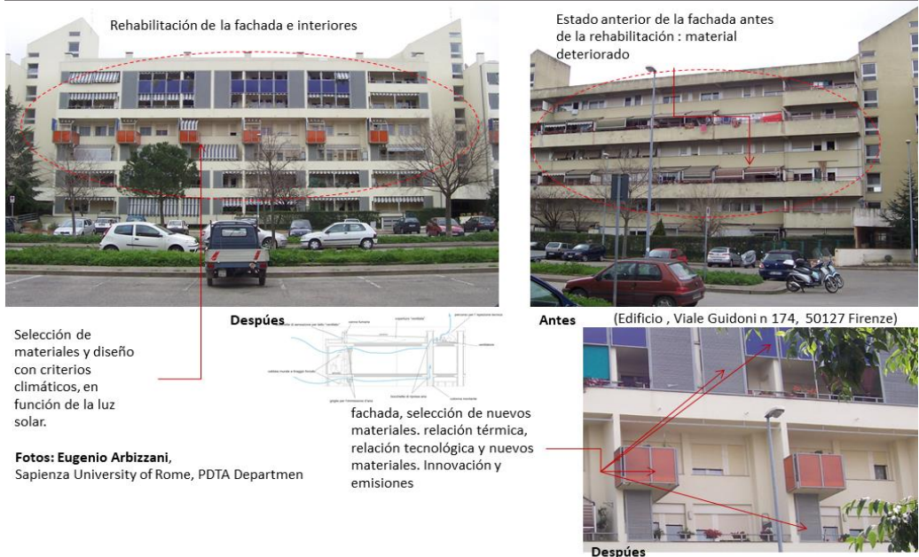
Panel 1.19. Fotos, cortesía de Arq. Eugenio Arbizzani, Caso: edificio residencial, fachada contemporánea rehabilitada con nuevos materiales y criterios climáticos.
