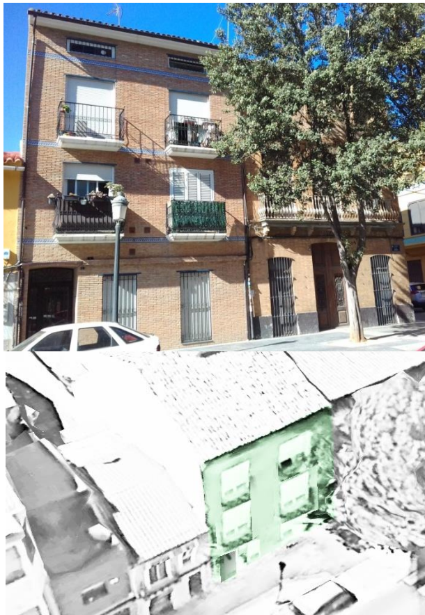
Foto 1.1. Caso-A. Foto César Arguedas, Fachada representativa de Edificio (Tipo 1) en Carrer de la Reina. Valencia- España. (Zona climática: B3).
