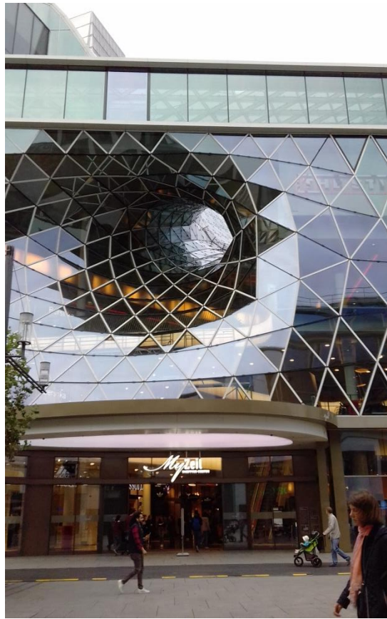
Imagen 1.1 -Caso1. Foto. César Arguedas; Alta energía embebida. Caso de Fachada en vidrio, metales, alto coste óptimo por uso de material de altas emisiones de CO2, innovación tecnológica en fachada térmica pero con uso de materiales de altas emisiones. (MyZeil, Arq. Fuksas , Bulevard Zeil). Frankfurt del Meno, Alemania
