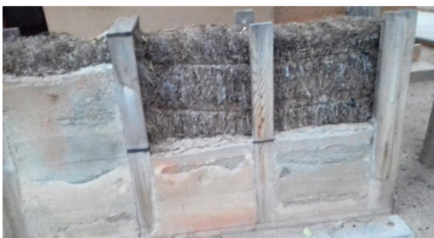
Imagen 1.5 -Caso 5. Foto. César Arguedas; Baja energía embebida. Edificación experimental a base de materiales de fibra natural térmica y arcilla con estructura de madera. Fachadas de bajo impacto de emisiones de CO2, procesos de materia prima local, obra in situ. Obra, Escuela Técnica Superior de Arquitectura de Barcelona (ETSAB). España.
