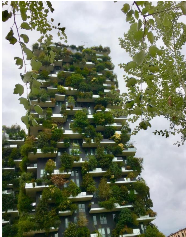
Imagen 1.3 -Caso3. Foto. Cortesía, DG. Karlen Zúñiga; Baja energía embebida. Caso de fachada con vegetación y control de soleamiento, sistemas térmicos, caso de fachada con estrategias pasivas con uso de materiales de impacto ambiental neutralizados por uso de vegetación. Bosco Verticale. Arq Stefano Boeri, Arq. Gianandrea Barreca, Arq. Giovanni la Varra. Milán, Italia.
