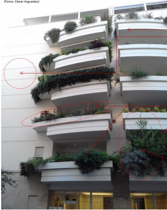
(Edificio ,VíaLima, Roma)
