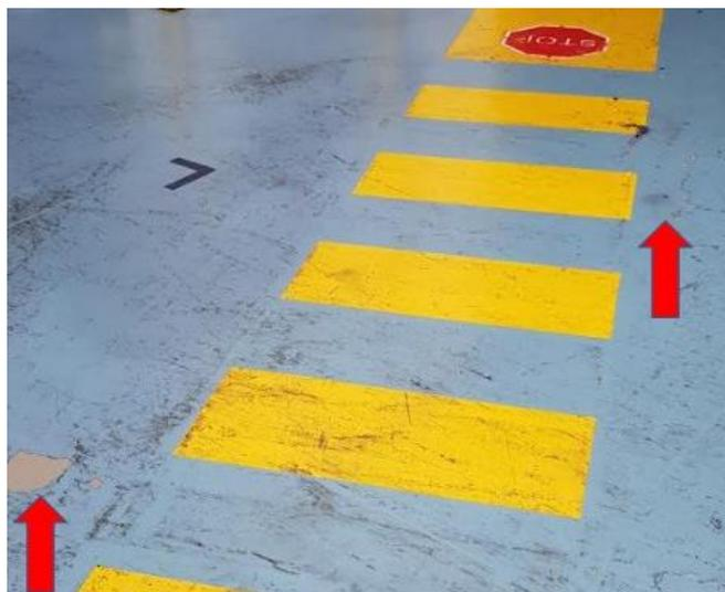
*Ilustración 40. Detalle del desgaste del suelo provocado por dejar embalaje directamente sobre él. - Fuente: elaboración propia*
