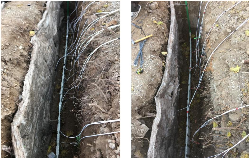
*Figura 8: Conexiones de las sondas en el interior de la zanja.*
