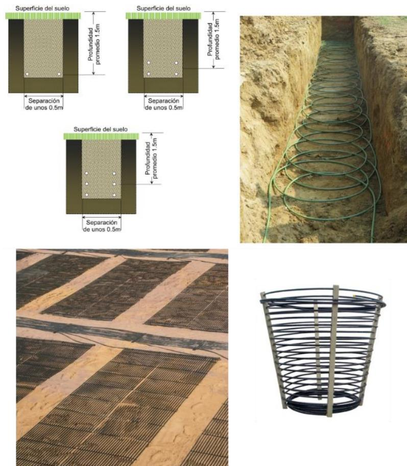
Figura 3: Configuraciones de tubos para intercambiadores horizontales: Arriba a la izquierda de 2, 4 y 6 tubos, arriba a la derecha 'Slinky', abajo a la izquierda alfombra de tubos y abajo a la derecha cesta de tubos.
