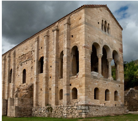
Fig. 76 Exterior de Santa María del Naranco, 842, Oviedo.
