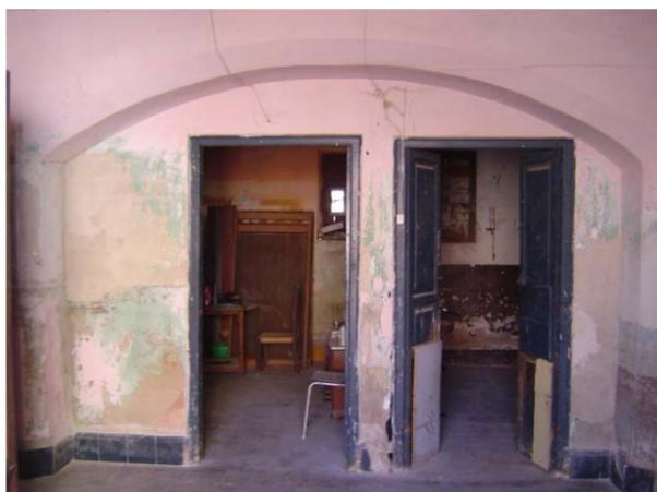
El muro de carga central posee un arco de descarga que permite abrir un gran hueco para acceder a las habitaciones 1 y 2:
