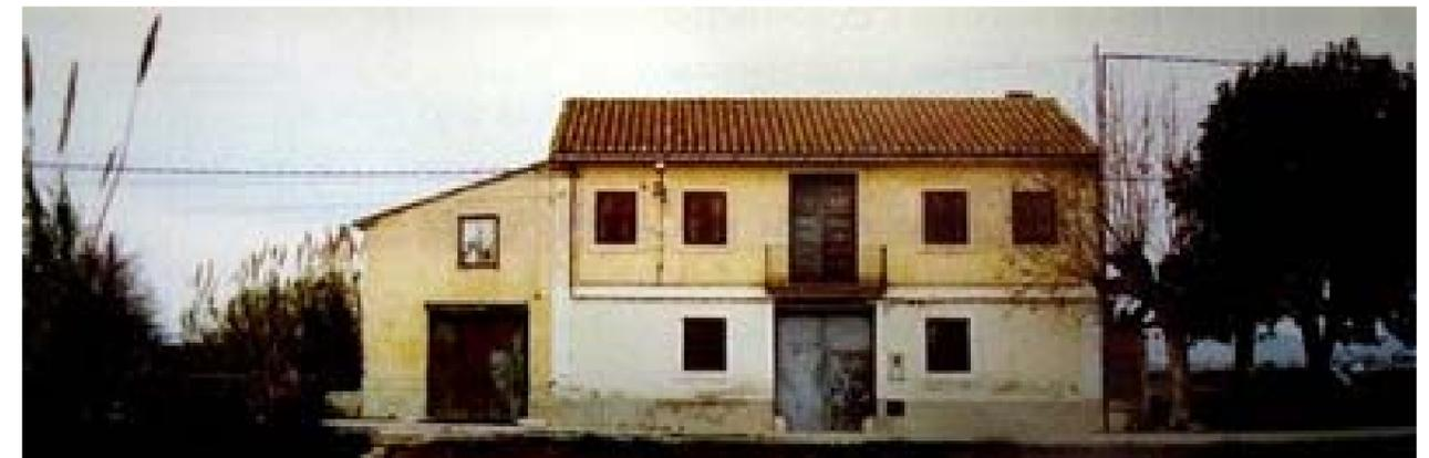
La cubierta se construye con un sistema de listones de madera y un entabacado de ladrillo, sobre el cual descansa el plano inclinado de las tejas sobre una capa de mortero. El alero se construye de obra, con un canalón de zinc.
