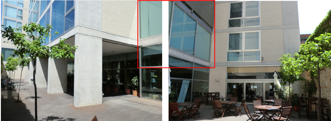
Imagen 26 y 27. Zona común 1 desde el exterior.
