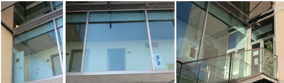
Imagen 28, 29 y 30. Zona común 2 desde el exterior.
