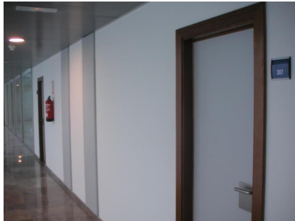
Imagen 32. Zona común 7 (acabados texturglas).
