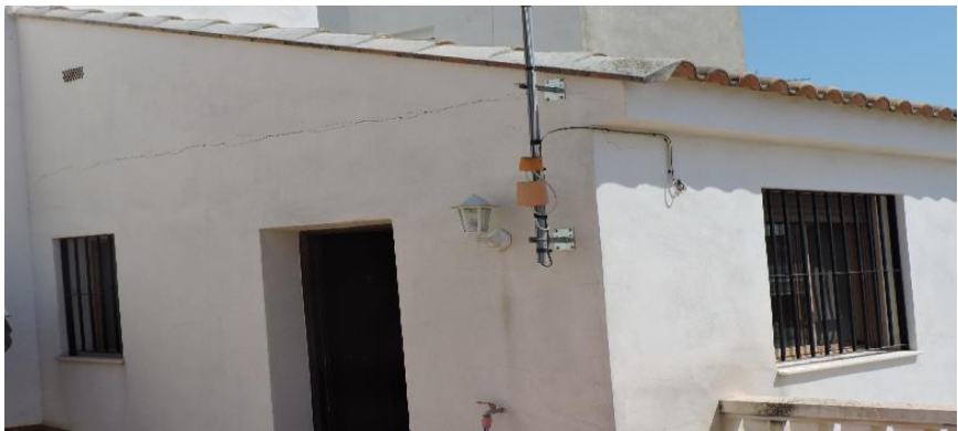
Imagen 8. Cubierta del lavadero. Fuente: elaboración propia.
