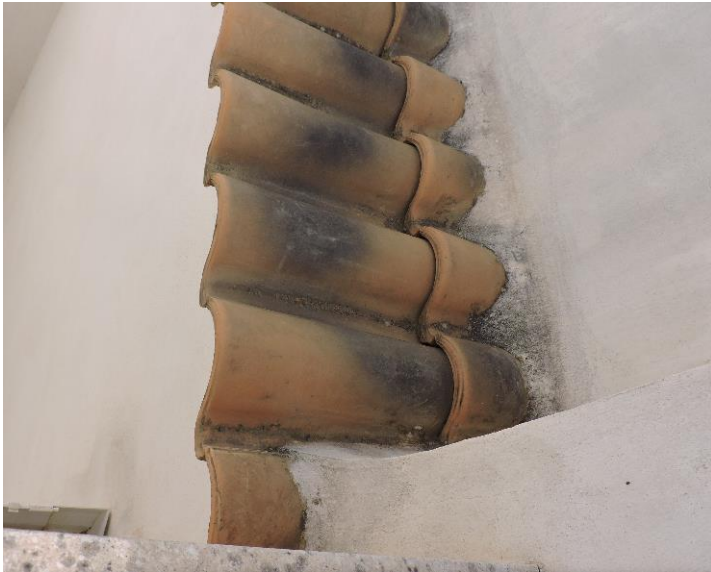
Imagen 7. Hueco de medianera de 35 cm de la casa vecina. Fuente: elaboración propia.
