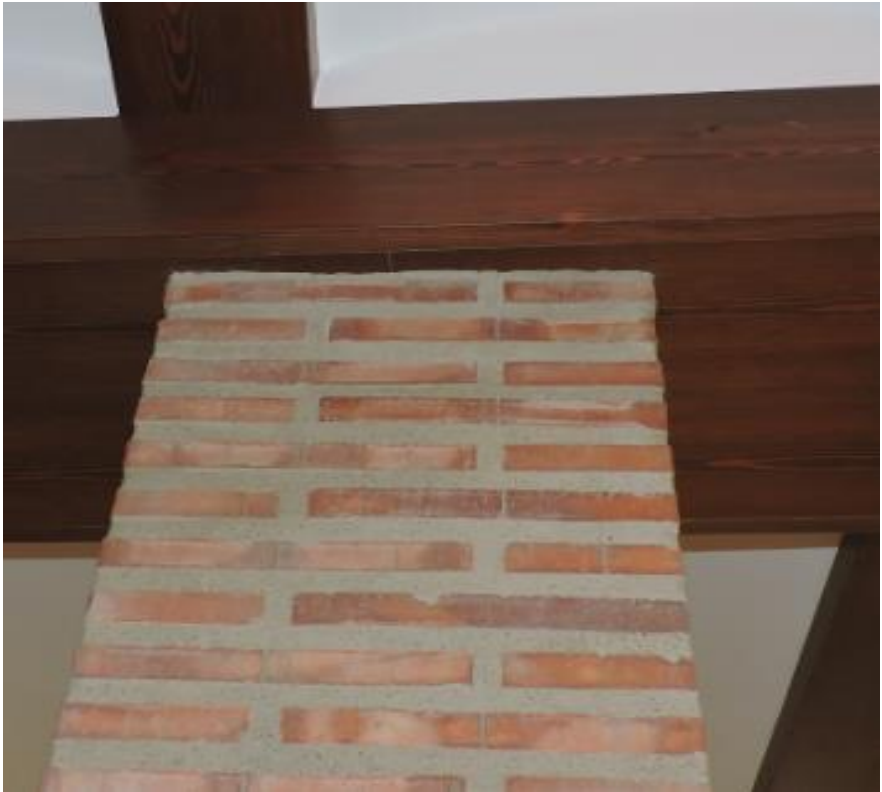
Imagen 11. Sustitución muro de carga. Fuente: Elaboración propia.
