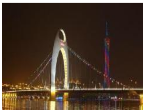
Figura 5-12 Puentes de Guangzhou
