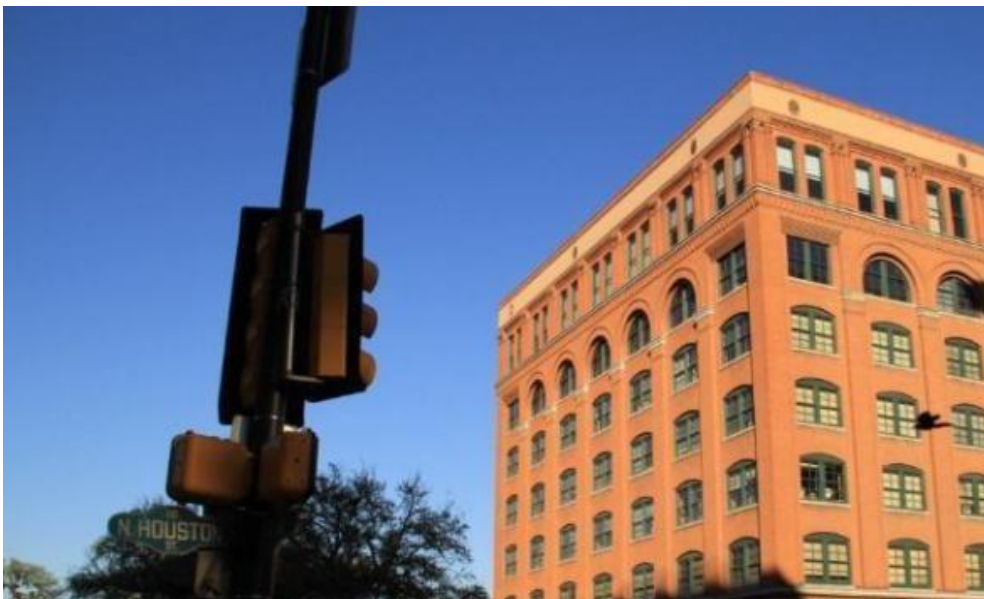
Figura 4-12 Edificios que destruyen la integridad
