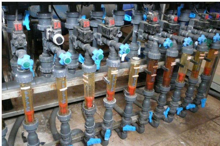
Figura 13: Sistema de fertirrigación adoptado en el cabezal
