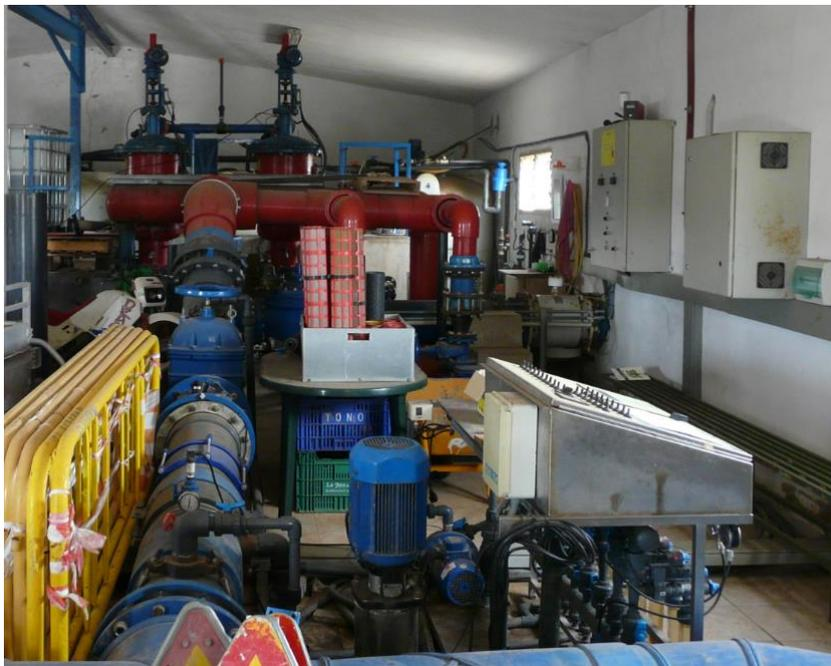
Figura 10: Interior del cabezal, en el fondo los equipos de filtrado de un color rojo, a la derecha el equipo de fertirrigación y en la parte baja la ramificación de la red para abastecimiento de los sectores
