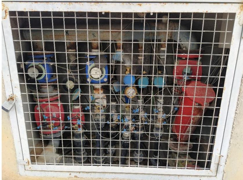
Figura 21: Detalle hidrante multiusuario, filtro caza piedras a la derecha en color rojo, y un total de seis tomas, cada una disponiendo de contador volumétrico y electroválvula
