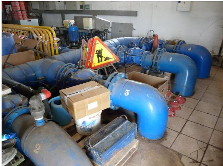
Figura 12: Ramificación redes secundarias a la salida del cabezal
