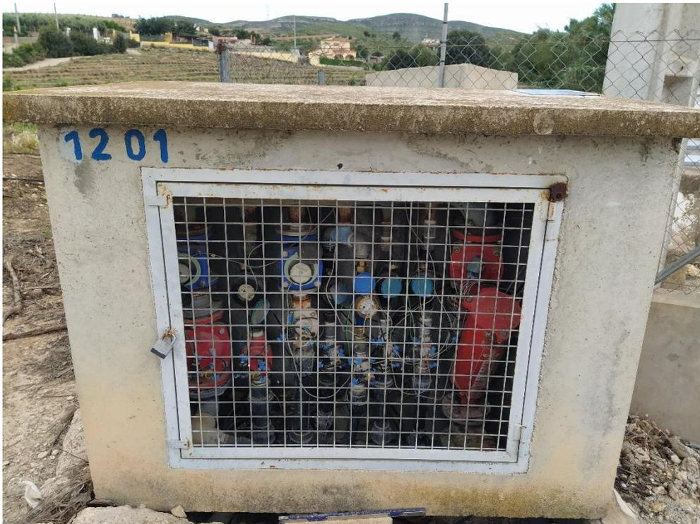
Figura 20: Vista de un hidrante multiusuario (H-1201)
