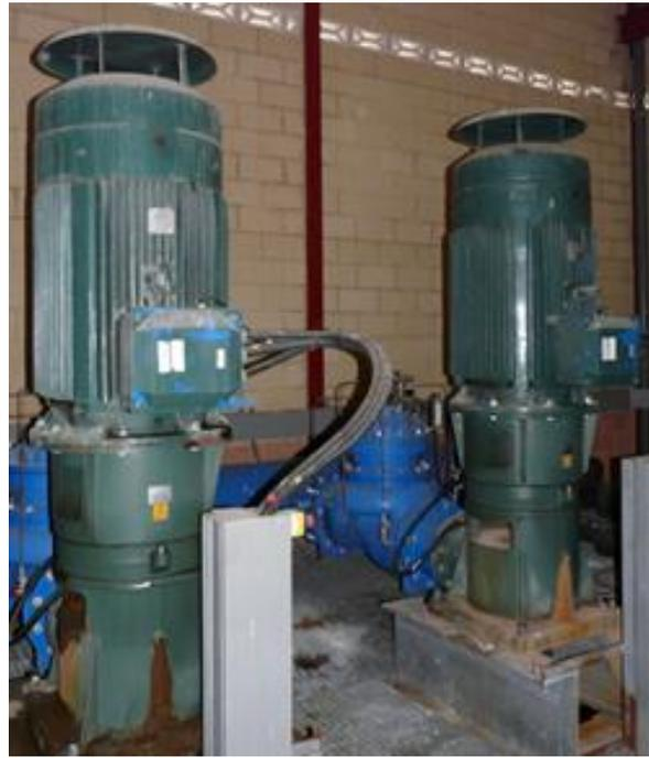
*Figura 4: Bombas centrífugas de eje vertical conectadas en paralelo*
