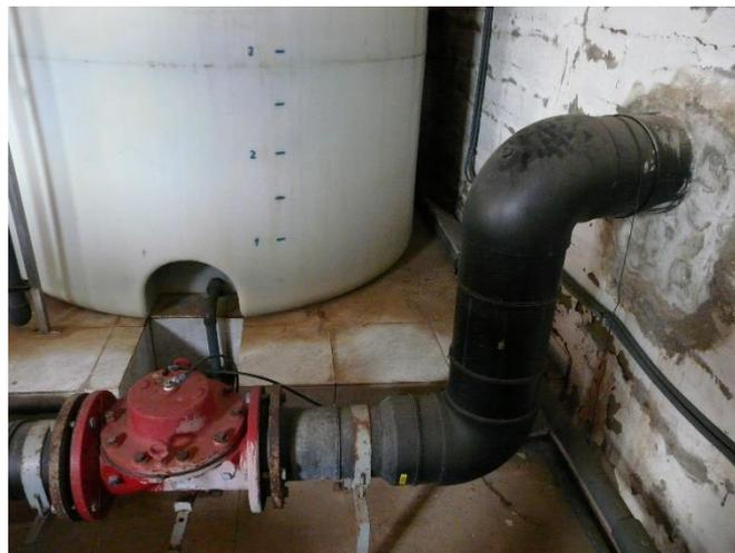
Figura 15: Tubería de entrada proveniente de la balsa Perdices y válvula de cierre
