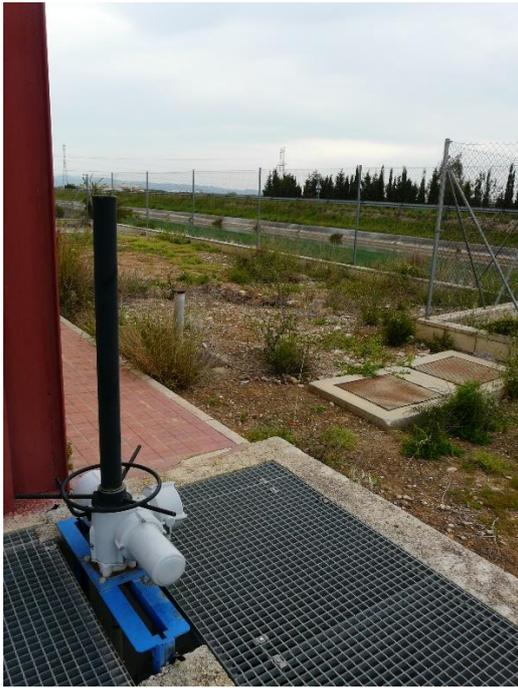
*Figura 3: Compuertas entrada del agua del canal a la zona de aspiración*
