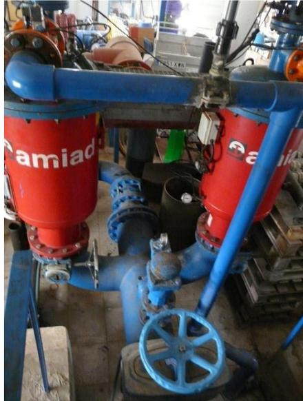
Figura 11: Equipo de filtrado cabezal, dos equipos de filtros de malla conectados en paralelo
