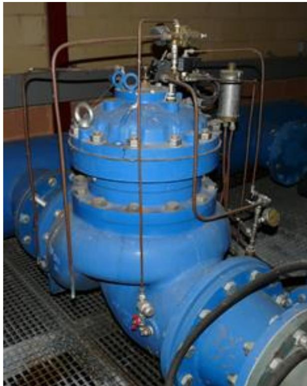
*Figura 5: Válvula de control de bombeo a la salida de la bomba*
