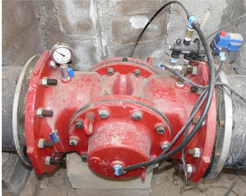
Figura 19: Válvula de doble membrana, conectada a la salida del cabezal Corral y empleada en caso de riego de la red 1.2 por bombeo para mantener la presión aguas arriba
