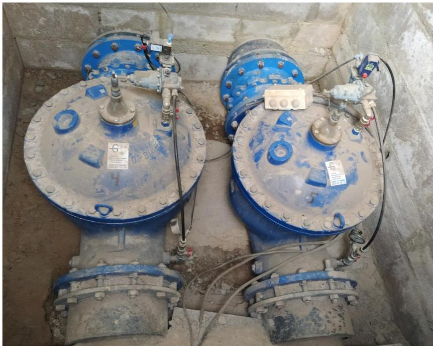
Figura 18: Válvulas reductoras de presión asociadas a la red 1, empleadas en el riego del sector 3
