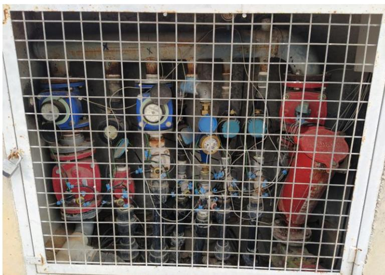
*Figura 4: Fotografía hidrante multiusuario y respectivos elementos que lo componen (fuente: propia)*
