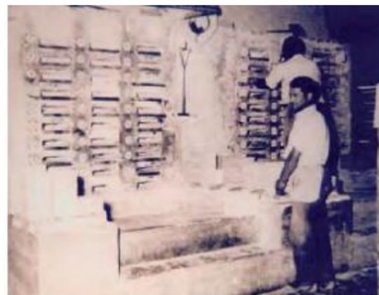
(Figura 622). Frente del horno de pasajes en funcionamiento en Onda. Tomado de V. Estall (2007).
