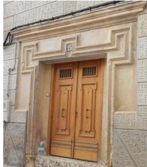
*“Fot.17, Fot.18. A la izquierda, arco apuntado de sillería en la Calle Colegio; a la derecha, arco adintelado de sillería en la calle Perete”*
