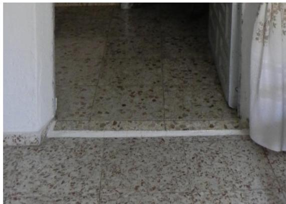
“Fot.43. Encuentro entre los dos pavimentos. Baldosa de terrazo 1 en la parte superior y baldosa de terrazo 2 en la parte inferior”
