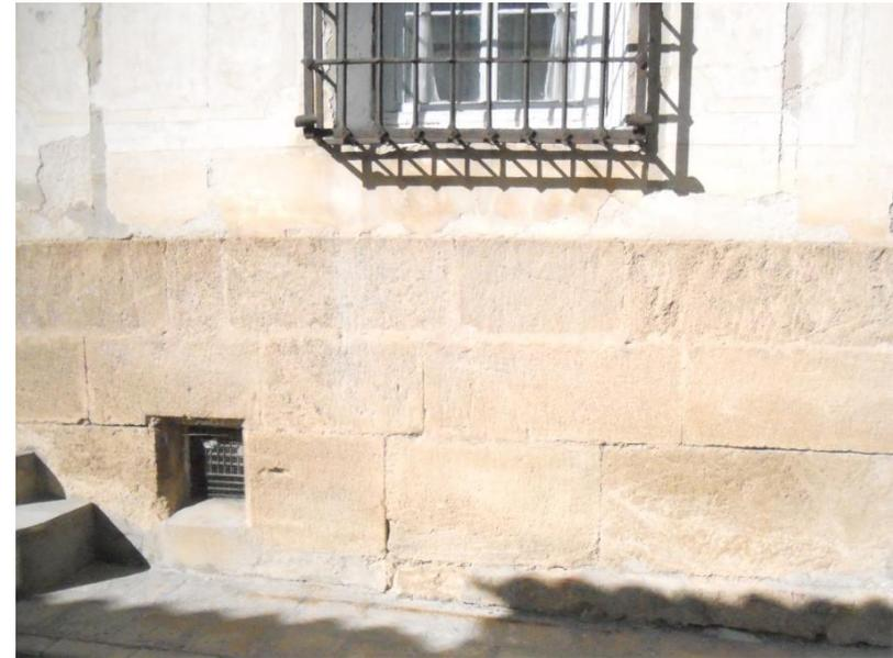
*“Fot.12. Zócalo de la fachada principal de la vivienda. Piezas labradas de sillería de piedra caliza”*
