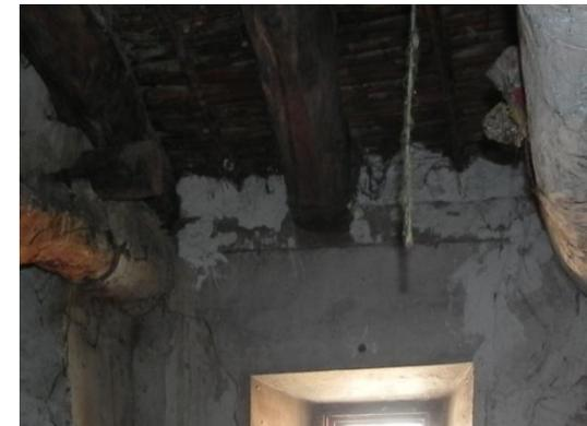
“Fot.35. Apoyo de pares sobre durmiente. Apoyo del tirante sobre dintel”
