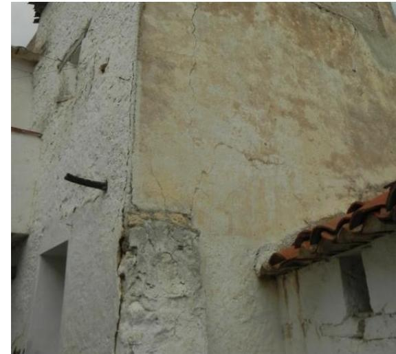
*“Fot.29. imagen muro enjalbegado a la izquierda y revestido con mortero de cal a la derecha”*
