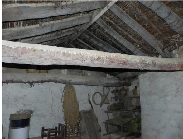
“Fot.36. Cubierta de par e hilera. Bloque 3”
