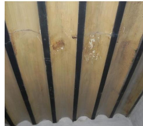
*“Fot.32. Forjado de viguetas de 8cm de anchura pintadas”*
