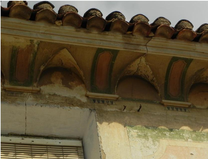
*“Fot.72. Imagen de la cornisa. Se observa el buen estado de las pinturas y la forma geométrica singular”*
