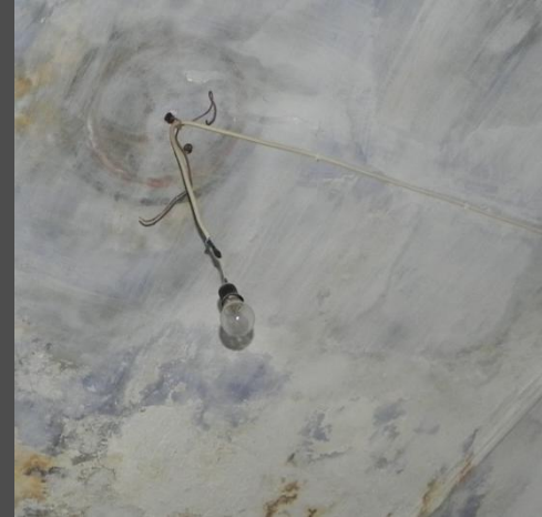
Ejecución nuevas instalaciones
