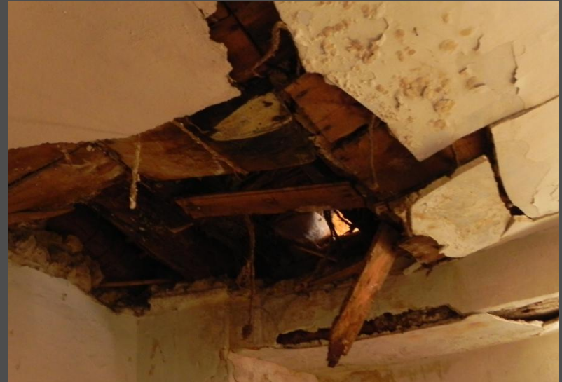
Reconstrucción forjados en mal estado
