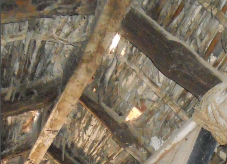
Cambio de cubierta integral
