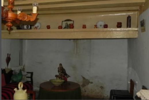
Rehabilitación de chimeneas para su uso
