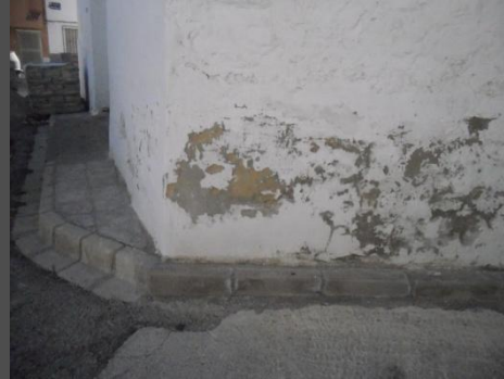
Eliminación humedades por capilaridad
