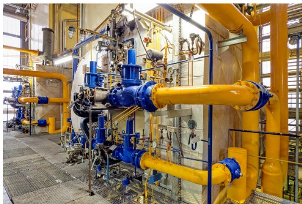
Figura 29. Bomba centrífuga en industria química. Fuente: Cindex
