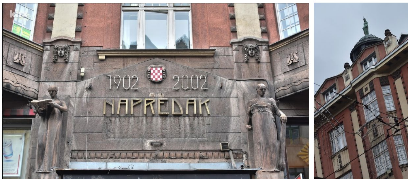
Figura 10. Izquierda: fachada del edificio de la asociación “Napredak” donde se aprecia el escudo croata, el nombre de la asociación y dos esculturas: Prosvjeta [Sabiduría] y Snaga [Poder], realizadas en piedra artificial por el escultor de Zagreb Robert Frangeš Mihanović, 1913. Derecha: escultura Croacia sobre el edificio de la asociación “Napredak” realizada por la empresa “Stegman i sinovi Budjevice”
