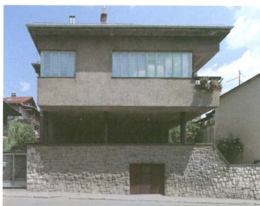
Figura 42. Doksat o voladizo de la Casa Kopčić , 1939, Sarajevo. Diseño del arquitecto Reuf Kadić.
