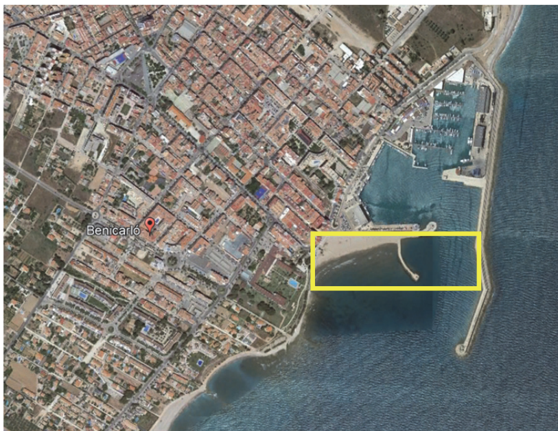
Figura 2. Vista aérea del puerto de Benicarló (Castellón) y área de actuación del proyecto. (Fuente: Google Maps y elaboración propia).
