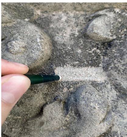
Figura 30. Cata de limpieza en seco con lápiz de fibra de vidrio
