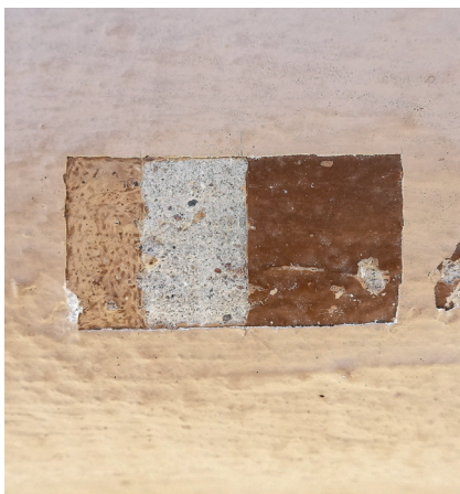
Figura 17. Cata estratigráfica mecánica sobre estrato de revestimiento pictórico
