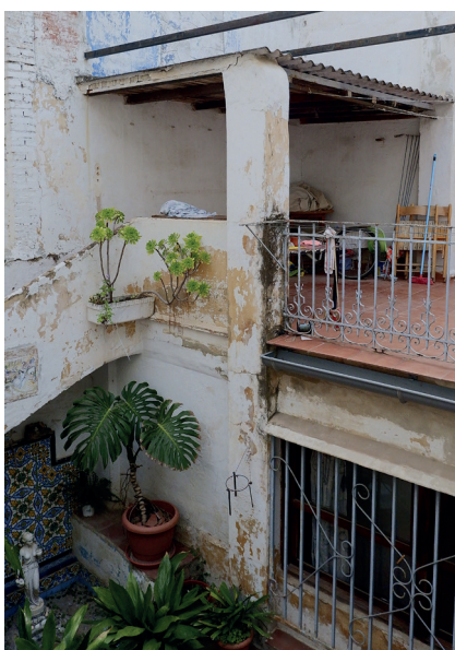
Figura 6 Techumbre sobre la primera altura derecha del patio..
