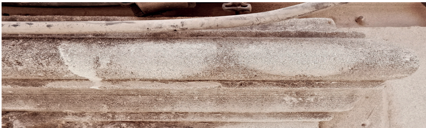
Figura 34. Resultado de limpieza de costra negra mediante empaco de EDTA.
