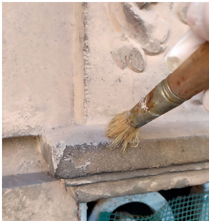
Figura 29. Cata de limpieza en seco con pincel de cerda gruesa
