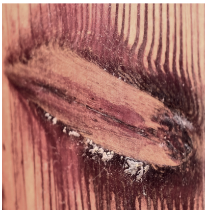
Figura 19. Nudo en forma de perno en la puerta de acceso principal.
