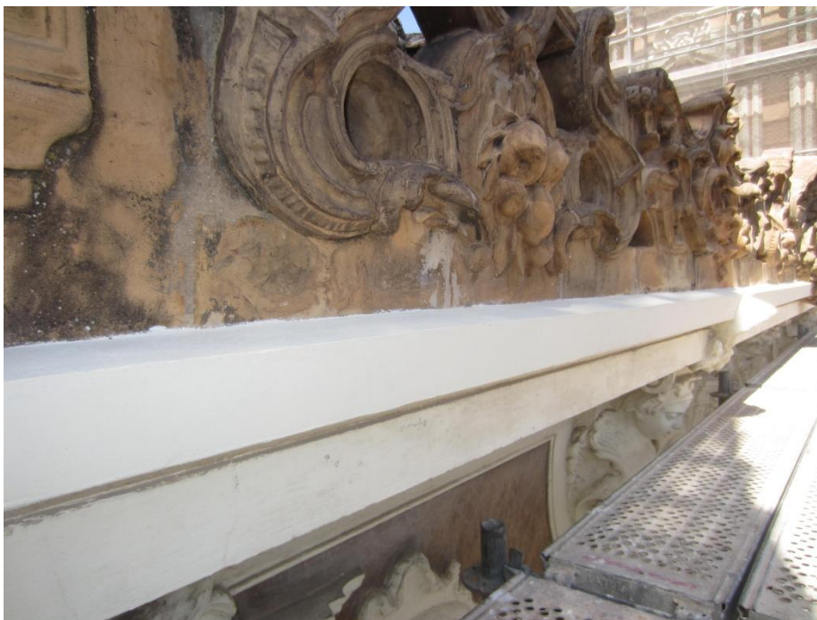
Figura 3.21. Estado actual de la cornisa Fuente: Foto de la autora
