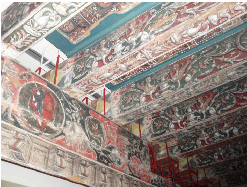
Figura 3.9. Fotografía las vigas recuperadas en la rehabilitación. Fuente: Foto de la autora
