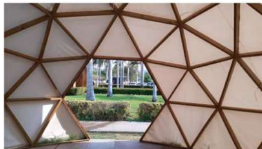
(d) Inside view of the final structure of the Dome.
