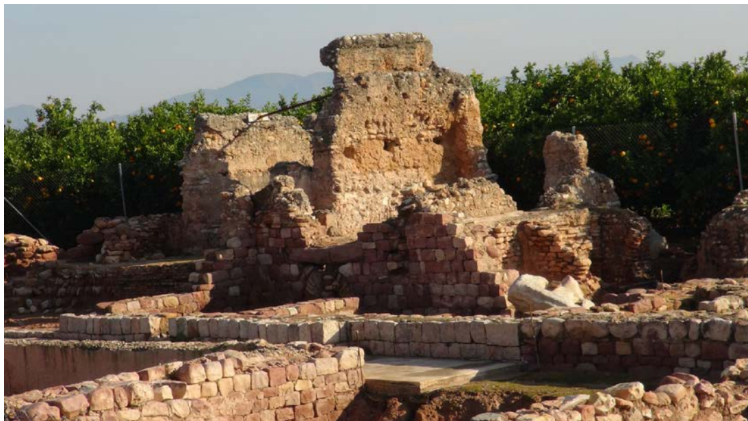
Muros de “opus caementicium” de casi 2.000 años en pie
